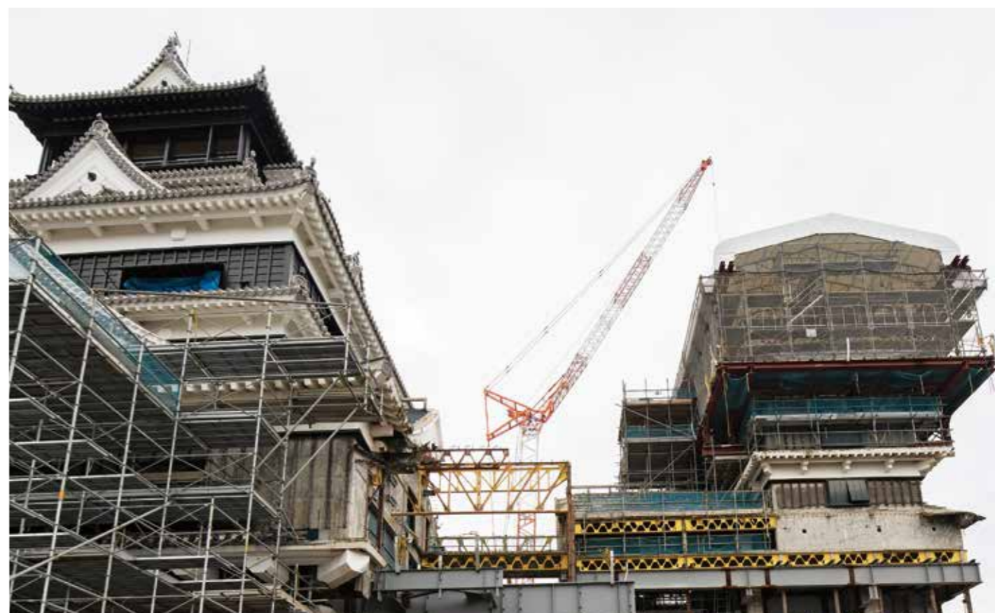
天守閣の復旧では、写真左側の大天守から張り出させた架構で右側の小天守の荷重を支える工法が導入されている。
