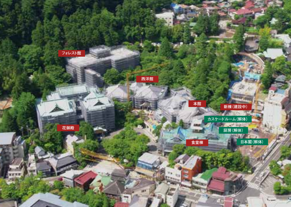
リニューアル工事の始まった富士屋ホテル。写真右下の交差点が宮ノ下の交差点。
