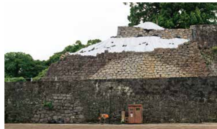
上／飯田丸五階櫓の復旧工事では建物を覆うように倒壊防止受構台を架設し、下部の崩落石垣を撤去、その後、櫓を解体した。（提供：熊本市） 下／飯田丸五階櫓の石垣からは写真上方に見える築城当時の石垣が出土した。
