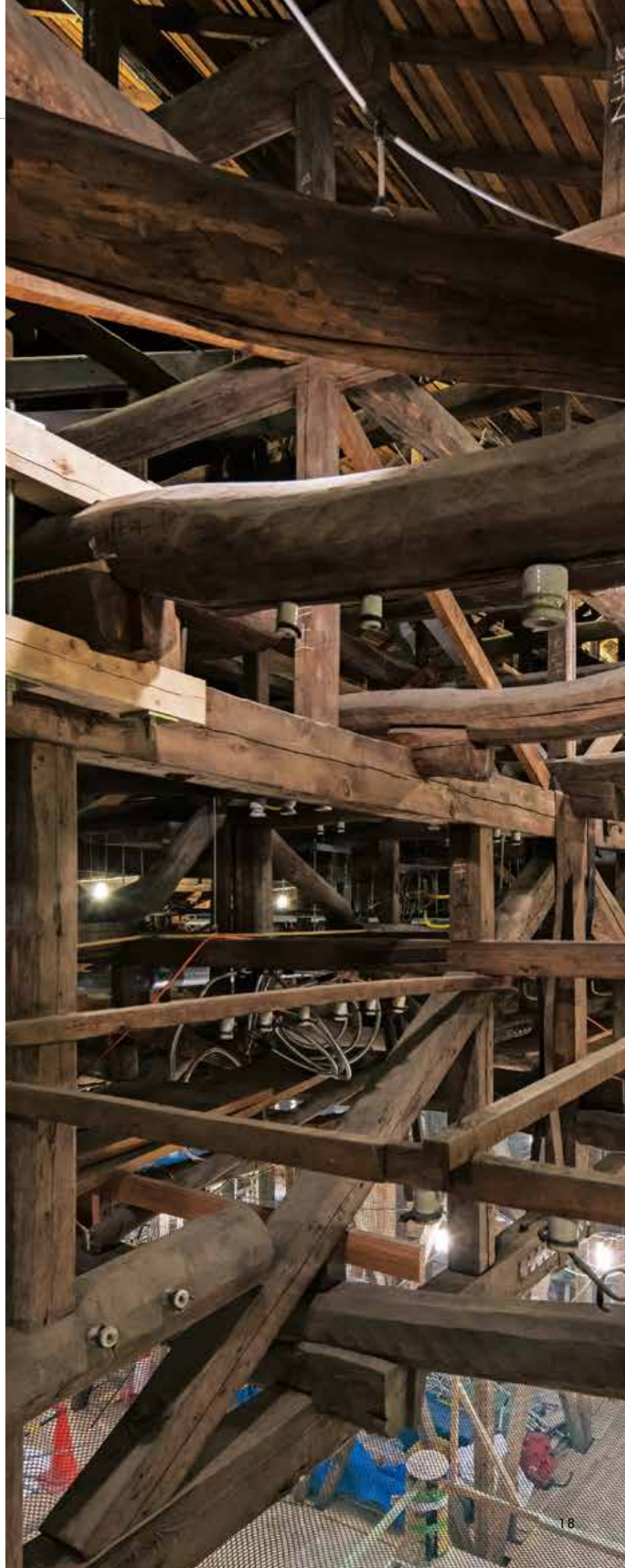
瓦の重量を拡散させる本館の小屋裏。かつての棟梁の技が光る。
