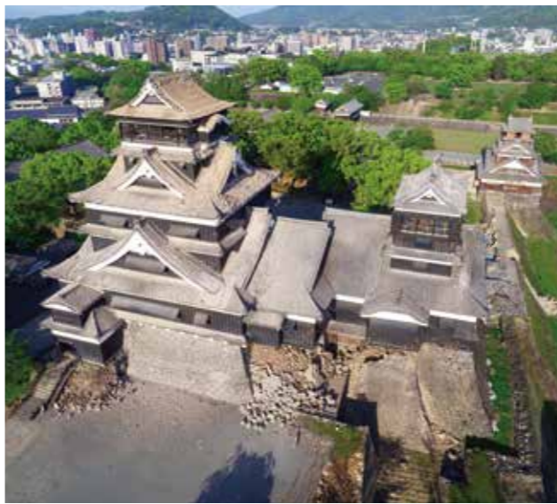
被災直後の天守閣 (提供:熊本市)
