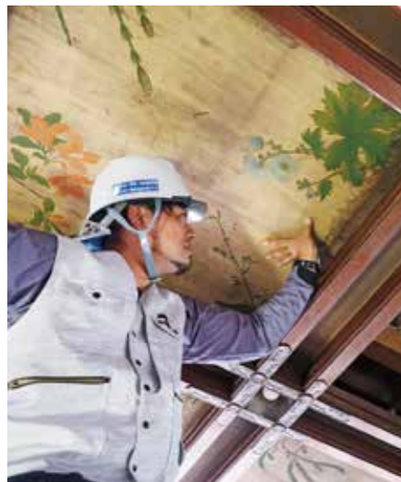
食堂棟・メインダイニングの天井画は一時撤去され補修が行われている。
