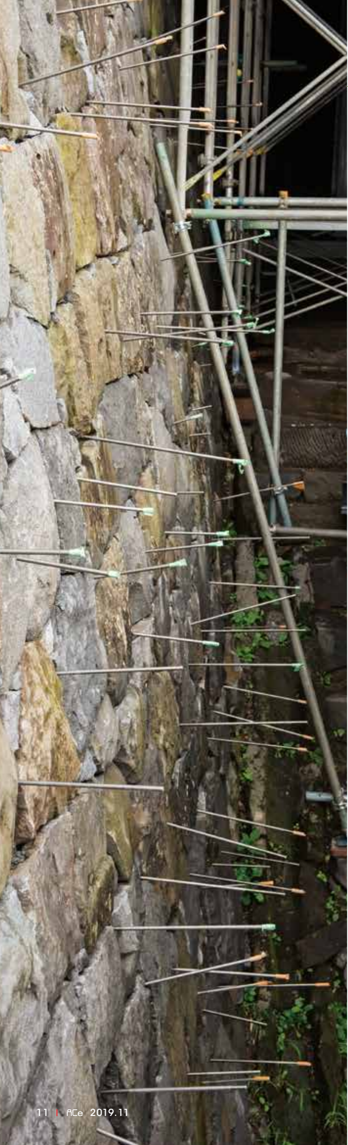
裏割り石内に埋設した石垣補強材を引っ張るステンレス全ネジボルト。 この後、石垣表面に高強度金網を設置して固定する。
