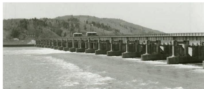
宮城県石巻市の飯野川可動堰(かどうせき)。同地の北上川はたびたび氾濫し、明治以来河川改修事業が進められた。昭和7(1932)年に完成したこのローリングゲートは当時の技術の粋を集めてつくられ、その実証実験は、物部が設立に尽力した内務省土木試験所の水理試験所が初めて手掛けたものだった。(写真提供：石巻市)
