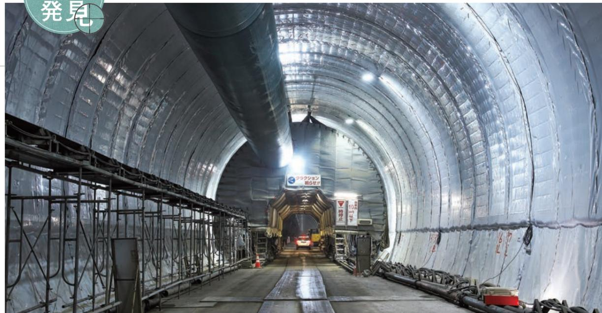
吹付コンクリートと防水シートの空隙に裏込め充填剤を施すことにより覆工コンクリートの曲面を滑らかに仕上げ、かつ確実な防水効果を実現する「FILM工法」を採用。防水シートに覆われたトンネルの姿は今しか見ることができない。その威容は未来都市の趣だ。
