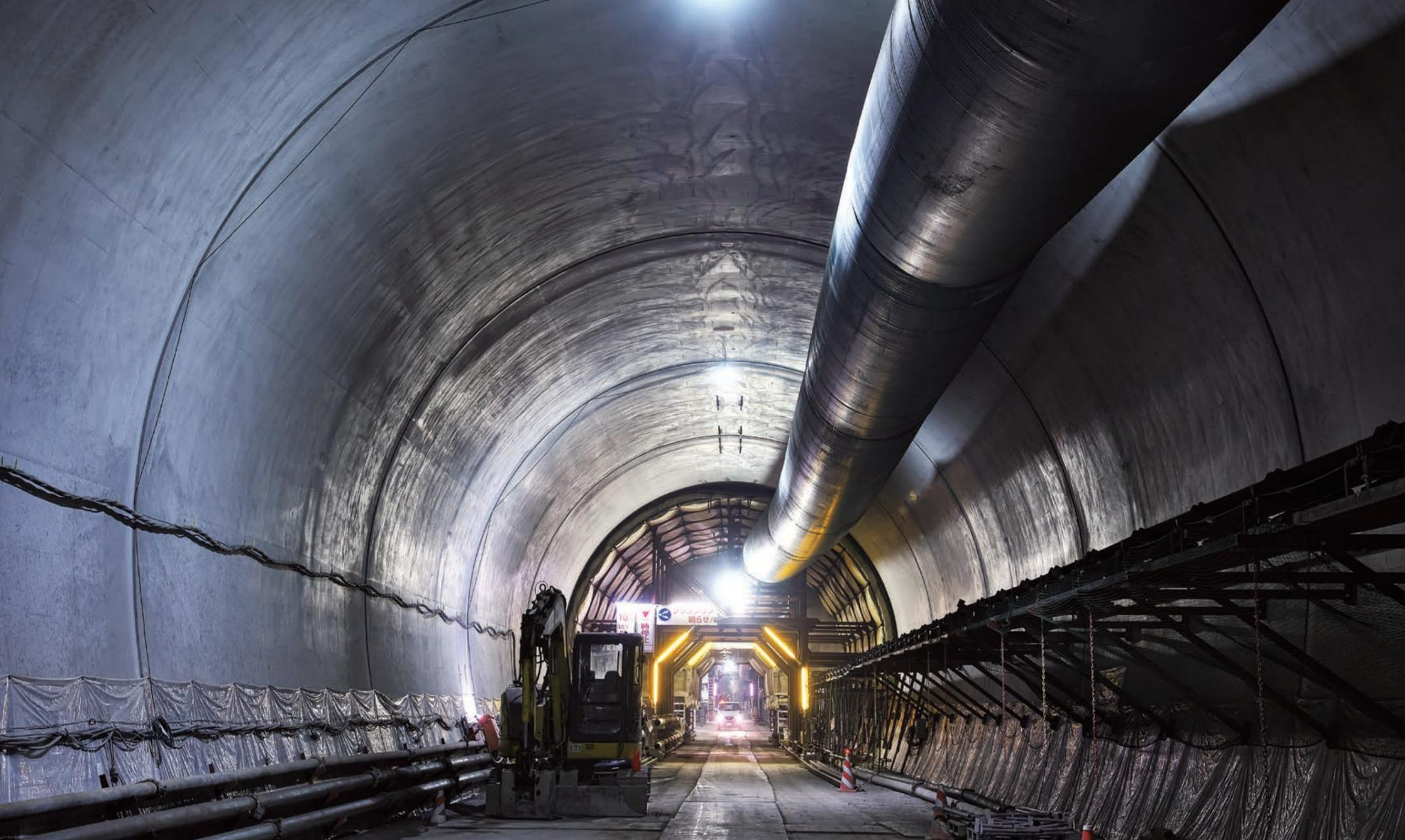
村山トンネルの覆工コンクリートは全体の約7割が完了し、国内最長となる陸上山岳トンネルの全容が現れている。この付近から切羽までは約700m。着工から約5年、北海道新幹線の札幌延伸に向け着々と施工を進めている。
