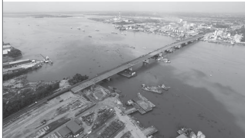
2018年10月時点のメグナ橋進捗状況、全景
