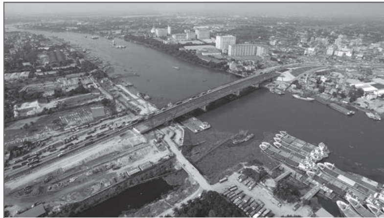
2018年10月時点のカチプール橋進捗状況、全景
