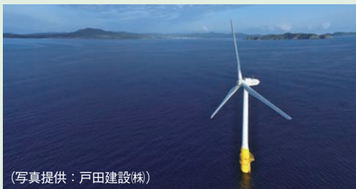
（写真提供：戸田建設㈱）
