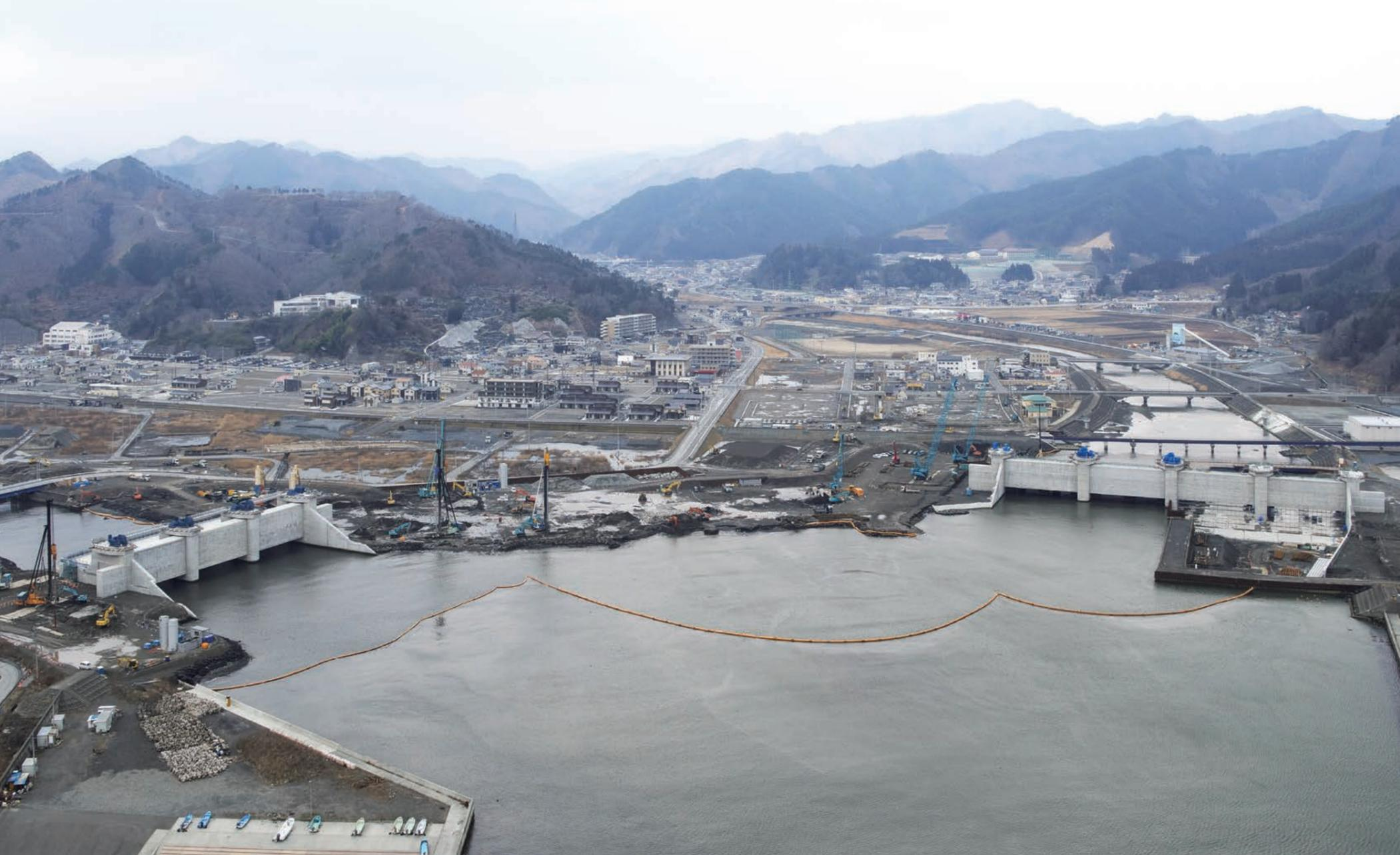
左に小鉤川水門、右側に大槌川水門がほぼ完成。その中央に防潮堤を建設する。約680mの擁壁が津波から大槌の町を守る。
