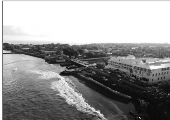
護岸施工状況
