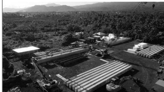
主桁製作ヤード
