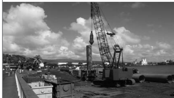
場所打ち杭施工状況
