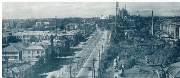
昭和5(1930)年頃、霞が関官庁街の風景。関東大震災により庁舎の大半が焼失し、官公庁は仮庁舎での執務を余儀なくされた。やがて本庁舎建設を担う大蔵省営繕管財局が組織され、大熊も所属。新庁舎は昭和初頭に次々と竣工していった。写真奥には建設中の国会議事堂も見える。(写真提供：一般社団法人 ジャパンアーカイブズ)
