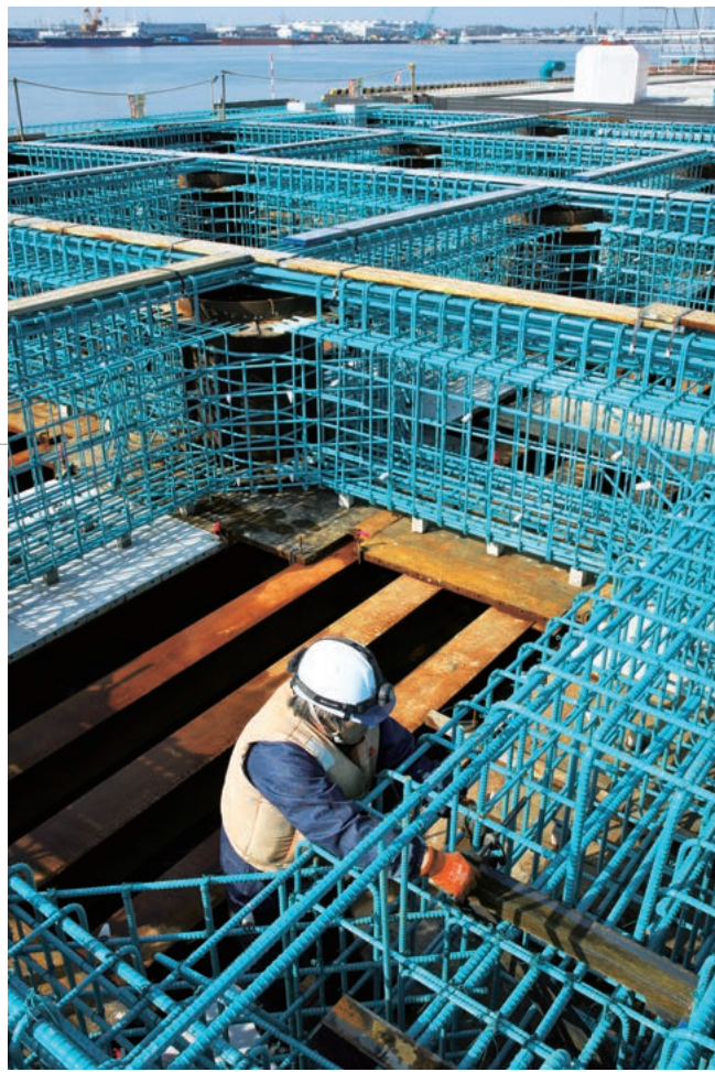
塩害を抑制するためエポキシ樹脂塗装鉄筋を採用した。
