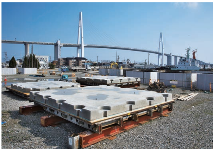
右／ヤード内には製作されたリプレイサブル床版が既に待機していた。 上左・上右／少しでもズレが生じると床版と座金、ボルトの収まりが困難になるため、施工は高い精度を必要とする。
