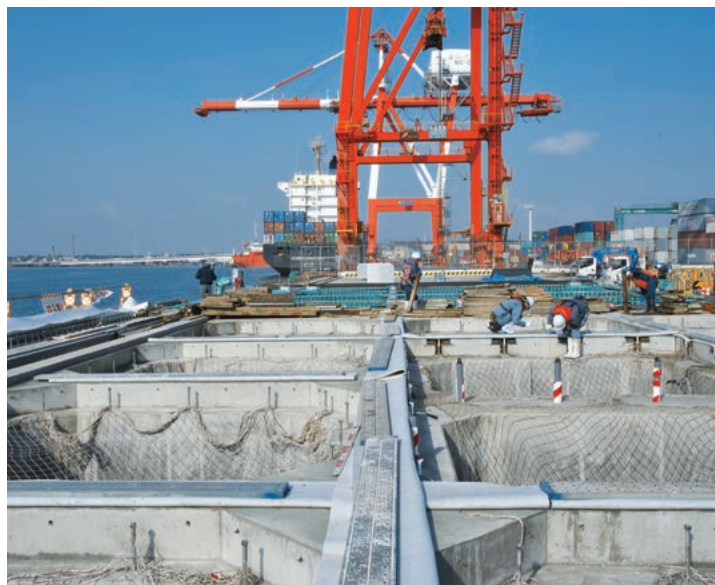
上／国際物流拠点として整備が進む伏木富山港の新湊地区。右下に見える新しい栈橋岸壁では、3スパンのうちクレーン側の1スパンがほぼ完成、残る2スパンの施工が進む。 下／リプレイサブル床版を配置する栈橋の上部工も進行中だ。
