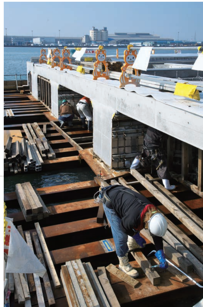
上／陸側から型枠を設置してコンクリートを打設、栈橋上部の基礎を構築する。下／工期を短縮するため1スパン目の施工中に、反対側の端部、3スパン目から着工した。そのため、真ん中の2スパン目の支保工は水平方向に抜くことができない。支保工を短く加工し、一度海中に沈め垂直方向に撤去する工法を採用した。
