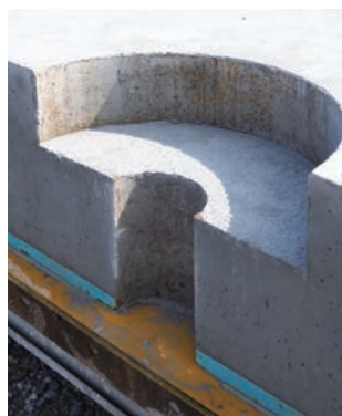
右／ヤード内には製作されたリプレイサブル床版が既に待機していた。 上左・上右／少しでもズレが生じると床版と座金、ボルトの収まりが困難になるため、施工は高い精度を必要とする。
