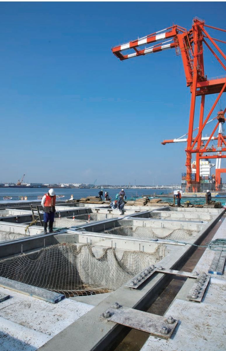
先に着手した端部のスパンが形になってきた。栈橋上部のこのマス目に、これから床版を設置していく。
