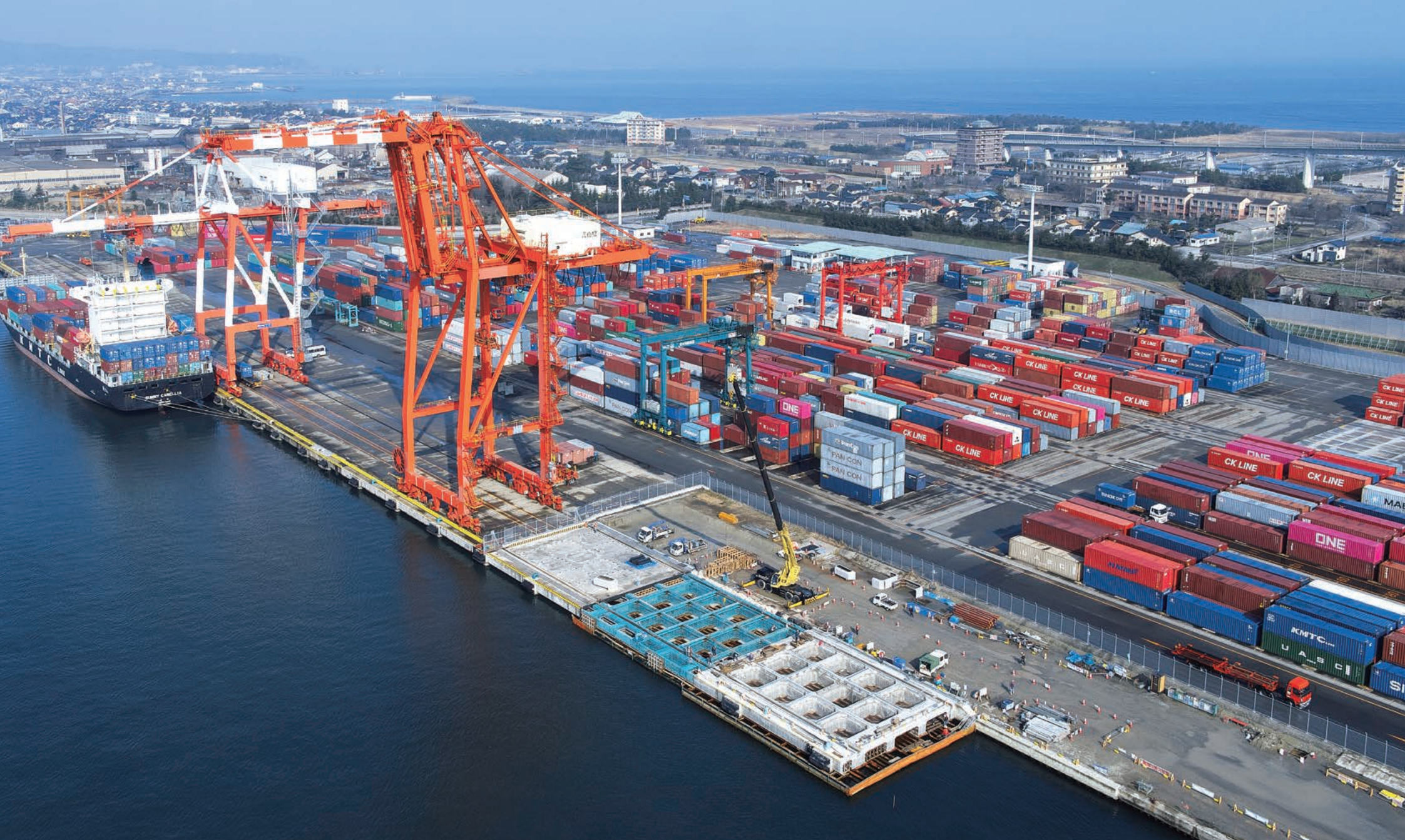
上／国際物流拠点として整備が進む伏木富山港の新湊地区。右下に見える新しい栈橋岸壁では、3スパンのうちクレーン側の1スパンがほぼ完成、残る2スパンの施工が進む。 下／リプレイサブル床版を配置する栈橋の上部工も進行中だ。
