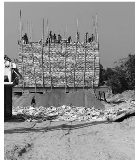
場所打ち杭の載荷試験
