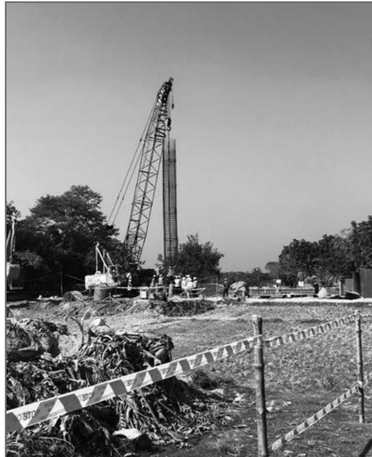
11月試験杭施工状況
