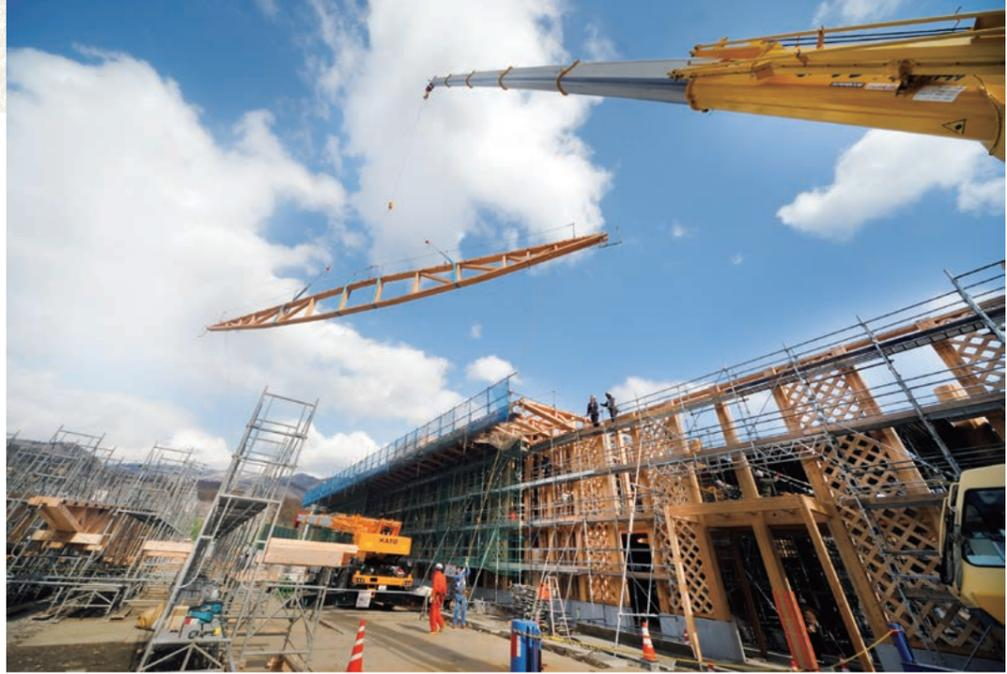
左／30mのレンズ型木造トラス梁は、半分を工場製作し、現地で地組、塗装後にクレーンで架設した。
