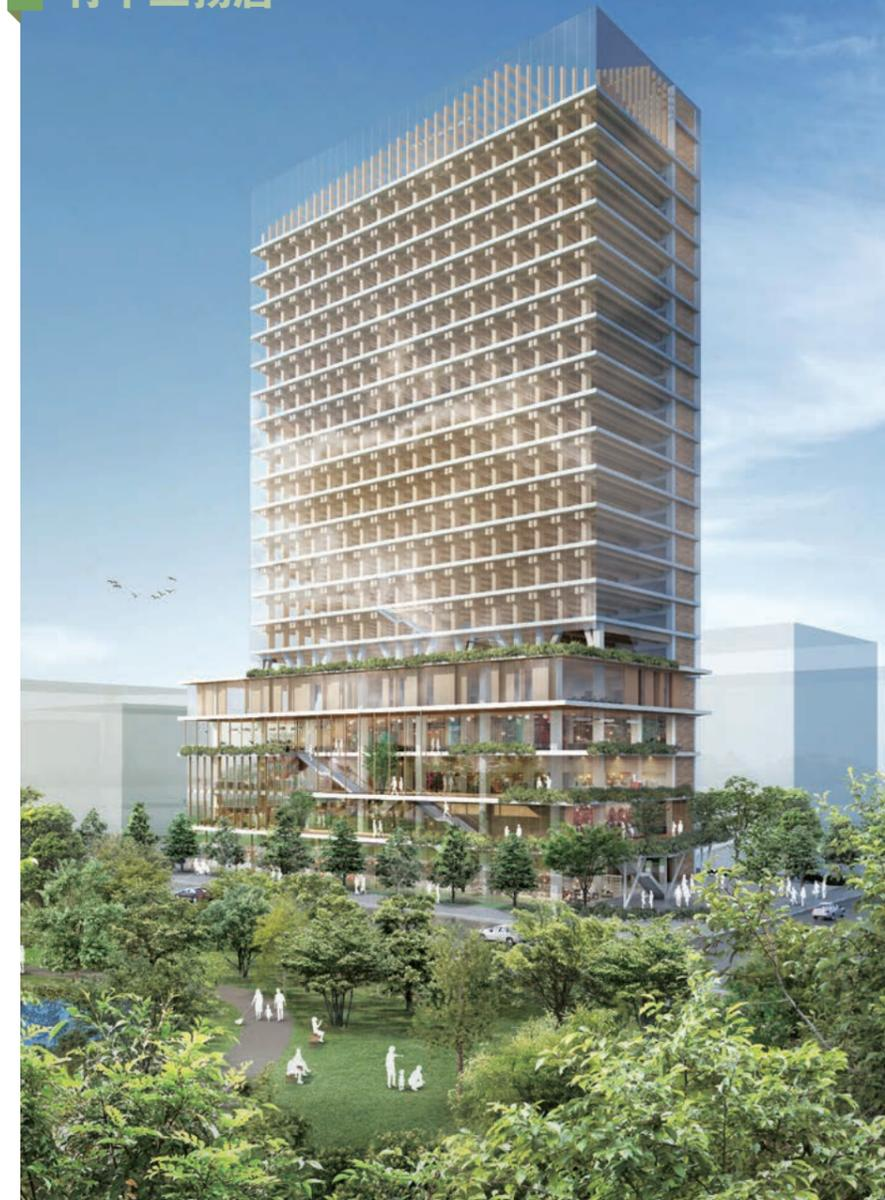
昨年、耐火集成材「燃エンウッド®」は、柱及び梁の開発において、耐火構造部材(2時間)の国土交通大臣認定を取得。これを受け、実プロジェクトへの適用に向けて高層木造建築モデル「Alta Ligna Tower」を試設計、公開した。人にやさしく、森林資源の循環モデルのシンボルとして注目を集めている。
