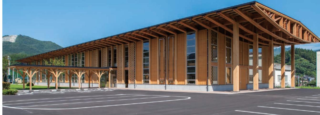
準耐火構造によって木の現しで建設された住田町役場。メンテナンスを繰り返しながら長期間使用できる木造建築の粋を集めた。地元の事業者が塗装や保護剤の増し塗りを自ら行えるように、理想的な材料や塗布面積などの情報提供を行った。
