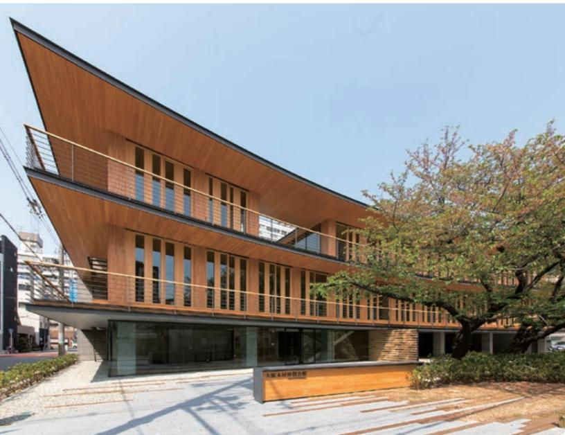
2013年に竣工した「大阪木材仲買会館」。「燃エンウッド®」を構造材として使用して建設された「木の殿堂」だ。館内の床、壁、天井はもちろん、建具や仕上げ材にも木材が使われ、木の魅力に満ちた日本初の耐火木造オフィスビルとして注目を集めた。2015年のBCS賞をはじめ、多くの建築関連賞を受賞している。
