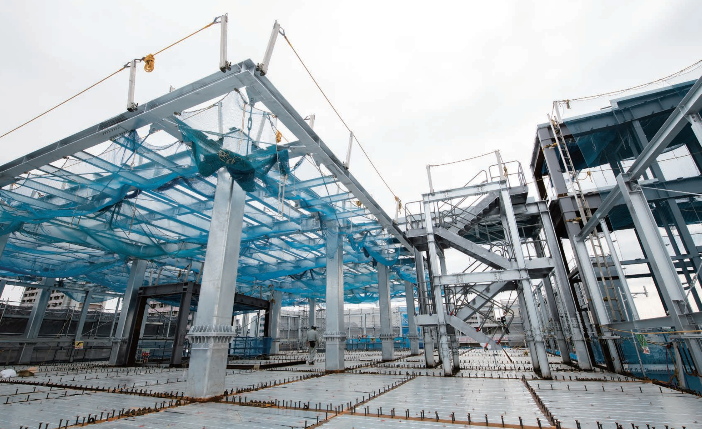
4階屋上に建ち上がった災害用ヘリポート。高さ約5m。鉄骨が組み上がり、このあと上面にデッキ床が施工される。大規模災害発生時に地域被災者の救援活動や災害支援助物資の運搬などに使われる。写真右側の鉄骨はエレベーターと連絡通路。
