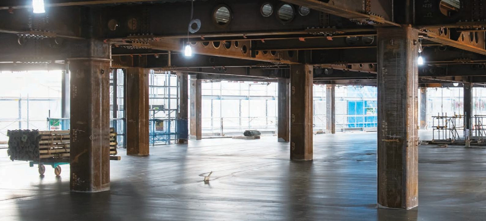
躯体工事中の2階。デッキ床にコンクリートを打設した状況。
