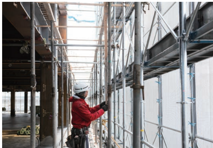
コンクリート打設が完了した2階バルコニーを見通す。2階は躯体に沿ってバルコニーが張り出しており、3階バルコニーを支持する型枠支保工の設置準備が進められている。
