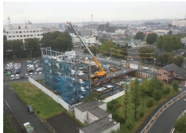
逃逃げ工法を採用した鉄骨建方。(写真提供：青木あすなろ建設(株))
