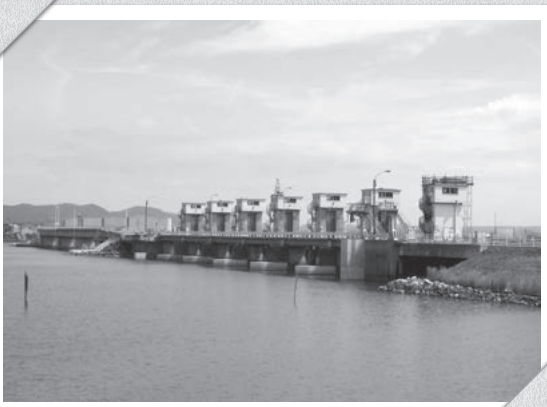
現在の百間川の河口水門 手前がローラーゲート、 向こうがライジングセクターゲート
