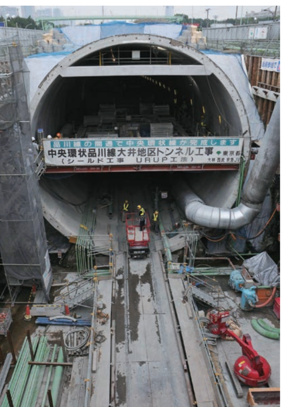
品川区中央環状品川線大井地区トンネル工事。2010（平成22）年撮影。全長の約9割が地下トンネル式の工事であるが、直径13.6mの泥土圧式シールド機を用いたシールド工法により、前例のない平均月進量約550mという高速度で施工された。（写真提供：東京都）
