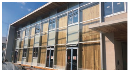
上/完成間近の嶺北森林管理署新庁舎。国の庁舎として初めて直交集成板(CLT)を本格活用した建築物。(写真提供:四国森林管理局) 左/嶺北森林管理署新庁舎の廊下。旧庁舎のサクラ材が再利用されている。(写真提供:四国森林管理局)
