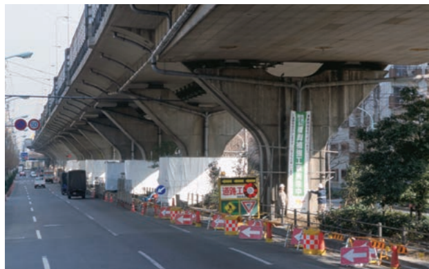
上／阪神・淡路大震災で横倒しとなった阪神高速道路。兵庫県神戸市東灘区で1995（平成7）年1月19日撮影。高速道路が倒壊し、関西の流通は大きな打撃を受けた。（写真提供：人と防災未来センター） 下／首都高速道路の橋脚耐震補強工事。東京都板橋区で1996（平成8）年撮影。全国で高速道路や橋梁などの耐震補強が進められている。（写真提供：東京都）
