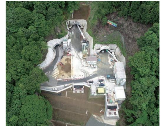
上・下/急峻な斜面に構築された坑口の施工ヤード。プラントの配置からダンプの走行ルートまで、安全性と施工性を両立する工夫が随所になされている。空撮(下)の左に見えるトンネルは工用の仮設トンネルだ。(下の写真提供: 三井住友建設(株))
