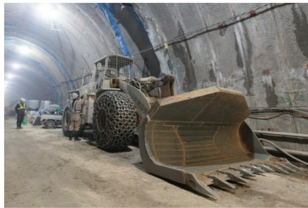
谷ヶ山トンネルはNATM工法で掘り進められる。切羽ではコンクリートの吹付けが行われている(上)。その背後に自由断面掘削機(左下)やホイールローダー(右下)が出番を待っている。坑内は漏水もなく、巨大な重機が所定の場所にコンパクトに収まり、整理整頓も行き届いている。
