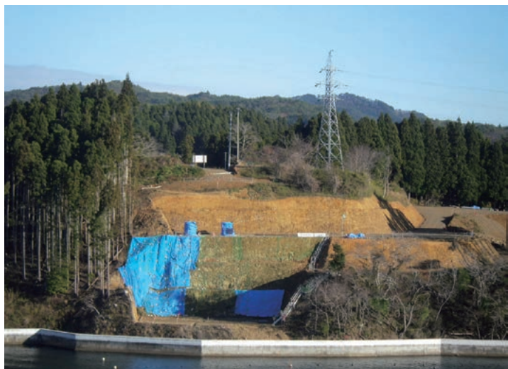
海に面した斜面(下)からひさしのように構台を張り出させ(上)、その上をヤードとして資材搬入、コンクリートの打設を行った。構台の直下は橋台の施工ポイントなので、海側の橋脚を構築した後に、ヤードを後退させ、改めて橋台の施工に着手した。(写真提供：㈱橋本店)
