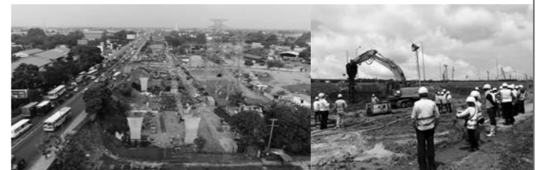
左/交通渋滞の既設主要幹線道路と並行して施工中のアプローチ橋脚 右/バイパスエリア：パワーブレンダー工法による軟弱地盤改良工事 技術研修会
