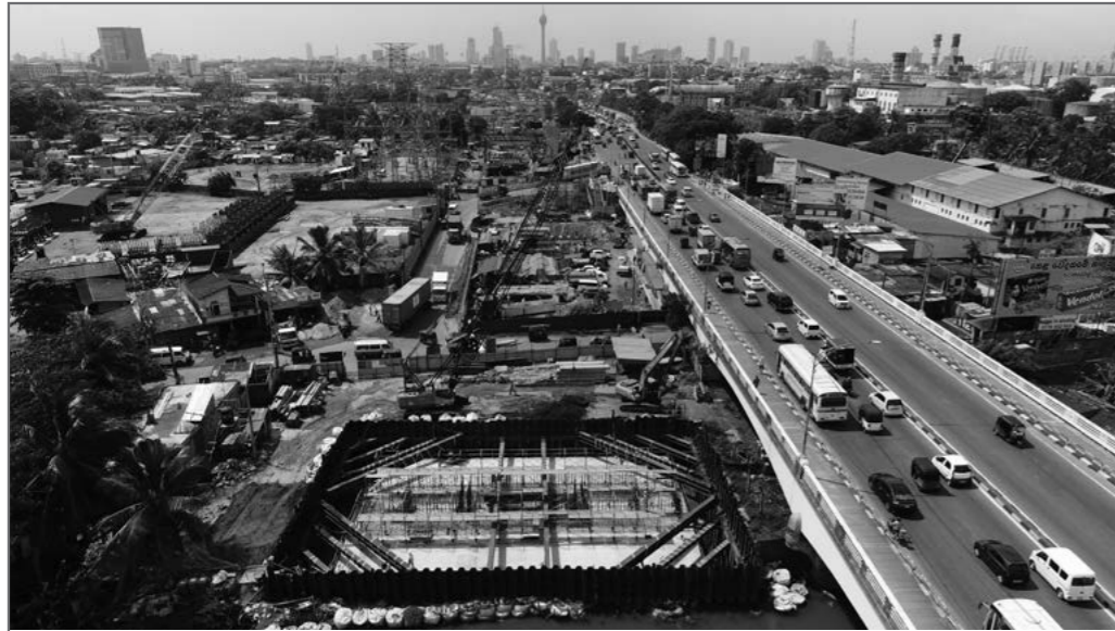
主塔部 バイルキャップコンクリート2,100㎡打設終了
