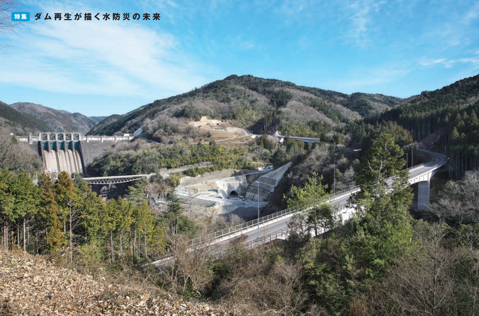
ダムサイトの全景。中央に転流工の吐口部が見える。堤体のすぐ下流側に架るのは工事車両用の「のぞみ橋」。仮設とはいえ土木学会田中賞を受賞した先駆的なPC吊床版橋だ。手前の橋は県道の付け替えに伴い昨年開通した「丸山大橋」。地域の重要な生活道路として欠かせない橋だ。
