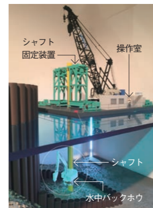
水中の作業を遠隔操作で行うことのできる水中作業機「T-iROBO UW」の水中イメージ。この現場では流入部前面の掘削で活躍した。
