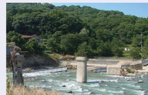
広島県広島市のJR芸備線白山駅～狩留家駅の区間で、三篠川に架かる鉄橋が濁流で橋脚ごと流出し、交通が遮断された。(2018年8月7日撮影 内閣府「平成30年7月豪雨による被害状況等について」より)
