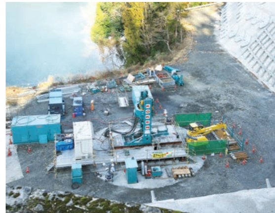
湖水を取り入れる呑口部の掘削がダム湖のほとりで進む(上)。ここから約30m地下に向けて掘削、トンネルはすでに直下まで到達している。吐口部は下流側からNATM工法で掘削した(右)。高速道路の2車線トンネルに匹敵する大断面だが、最大で30%以上の急勾配だ。
