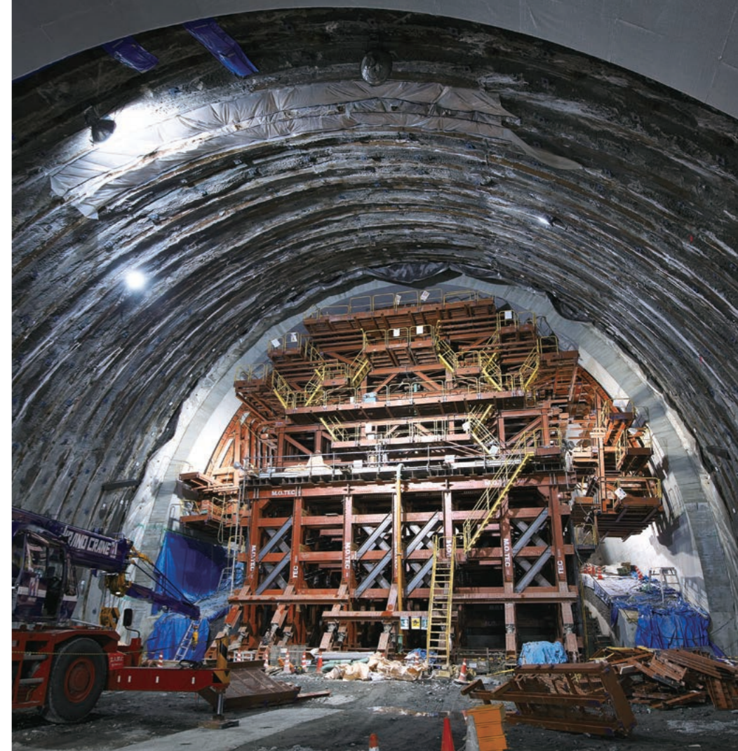
減勢池部は吐口部方向に向かって内空が広がっていく構造なのでセントルは移動するたびに組立てと解体を繰り返す。軟弱な地盤が確認された箇所には水平方向からの土圧に耐えるためトンネルの両側面下部にRC円柱支保工を施した。
