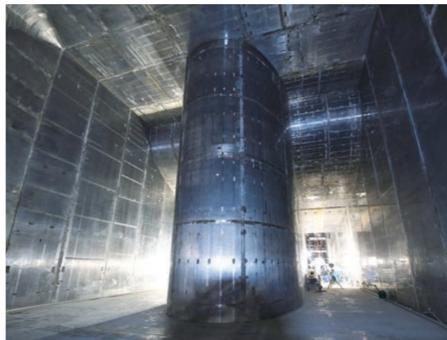
ゲート室部放流管の内側はステンレスで覆われている。この先にゲート装置が設置されている。竣工後は常に満水状態になるため、この光景を見ることができるのは今だけだ。
