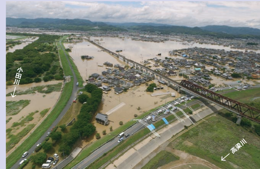
広島県広島市のJR芸備線白山駅～狩留家駅の区間で、三篠川に架かる鉄橋が濁流で橋脚ごと流出し、交通が遮断された。(2018年8月7日撮影 内閣府「平成30年7月豪雨による被害状況等について」より)
