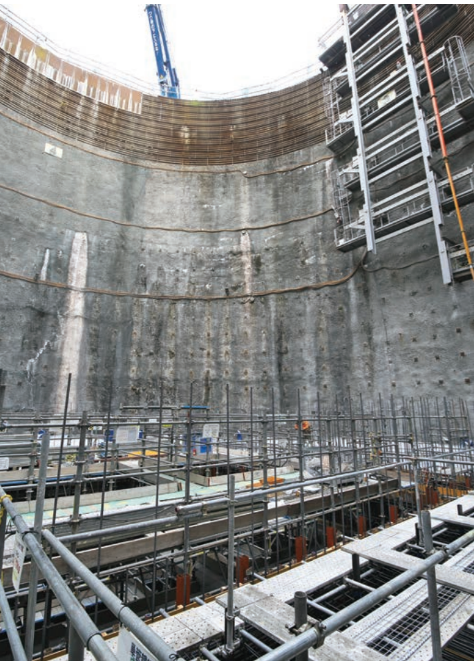
トンネル式放流設備の中間付近に位置するゲート室部の立坑。直径24m、深さ50mの巨大な立坑で、流入部から取り込まれた水の放水量を調整する主ゲートをこの場所に設置する。
