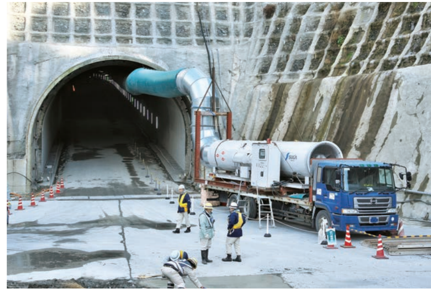
湖水を取り入れる呑口部の掘削がダム湖のほとりで進む(上)。ここから約30m地下に向けて掘削、トンネルはすでに直下まで到達している。吐口部は下流側からNATM工法で掘削した(右)。高速道路の2車線トンネルに匹敵する大断面だが、最大で30%以上の急勾配だ。
