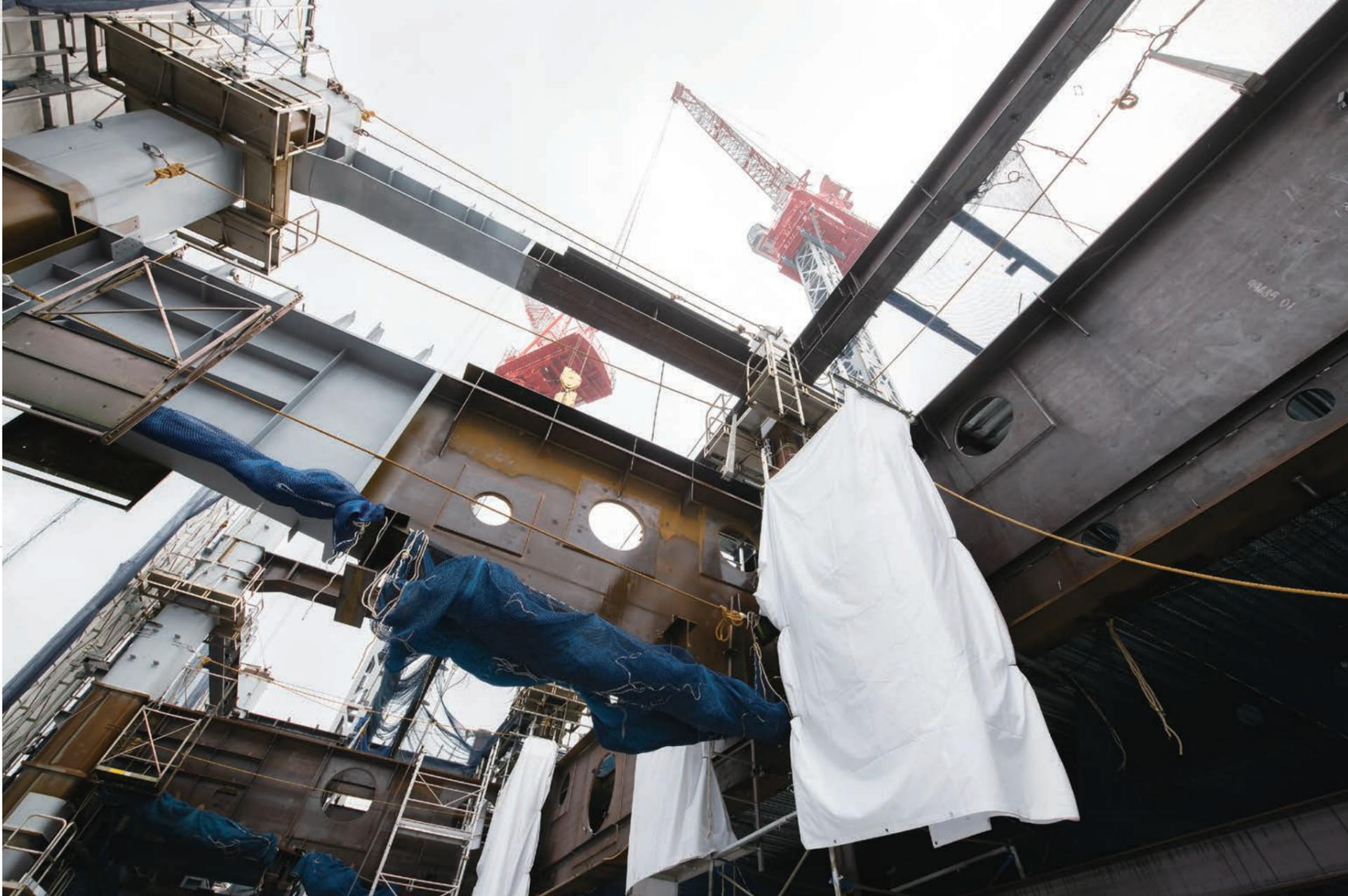
建物は17階までがオフィスフロアや一部商業施設等で、18階以上は住居フロアとなる。17階以下と18階以上では構造が大きく異なるため、間に大きな梁を挟み、構造の切り替えを行う。写真中央に丸い穴が開いている梁があるが、これが17階と18階を切り替えるための大きな梁だ。
