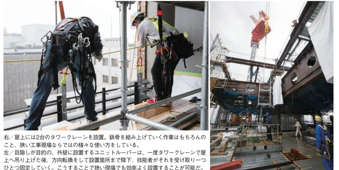
右/屋上には2台のタワークレーンを設置。鉄骨を組み上げていく作業はもちろんのこと、狭い工事現場ならではの様々な使い方をしている。
