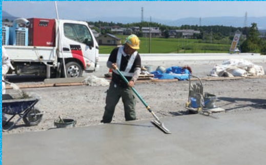
② 新名神菟野舗装工事（中部支店） → コンクリート舗装班を対象に
