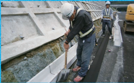
① 東北中央道上山舗装工事（東北支店） → 高齢技能者を対象に現場での運用試験
