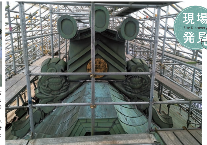
右／改修前の「鬼瓦」。上部に円筒状の「経の巻」、左右に牡丹の彫刻を打ち出した「鱒（ひれ）」が取り付けられている。中央の銚金物は宗紋の抱き牡丹。本体から経の巻の上まで高さは1.3m。（写真提供：松井建設様） 上／「鬼瓦」の木下地。銅板を被せて打ち出し、木下地とともに棟に取り付ける。既存の材はほとんど健全な状態が保たれていた。上部には「経の巻」、両側に「鱒」などを、それぞれ銅板を打ち出して取り付ける。
