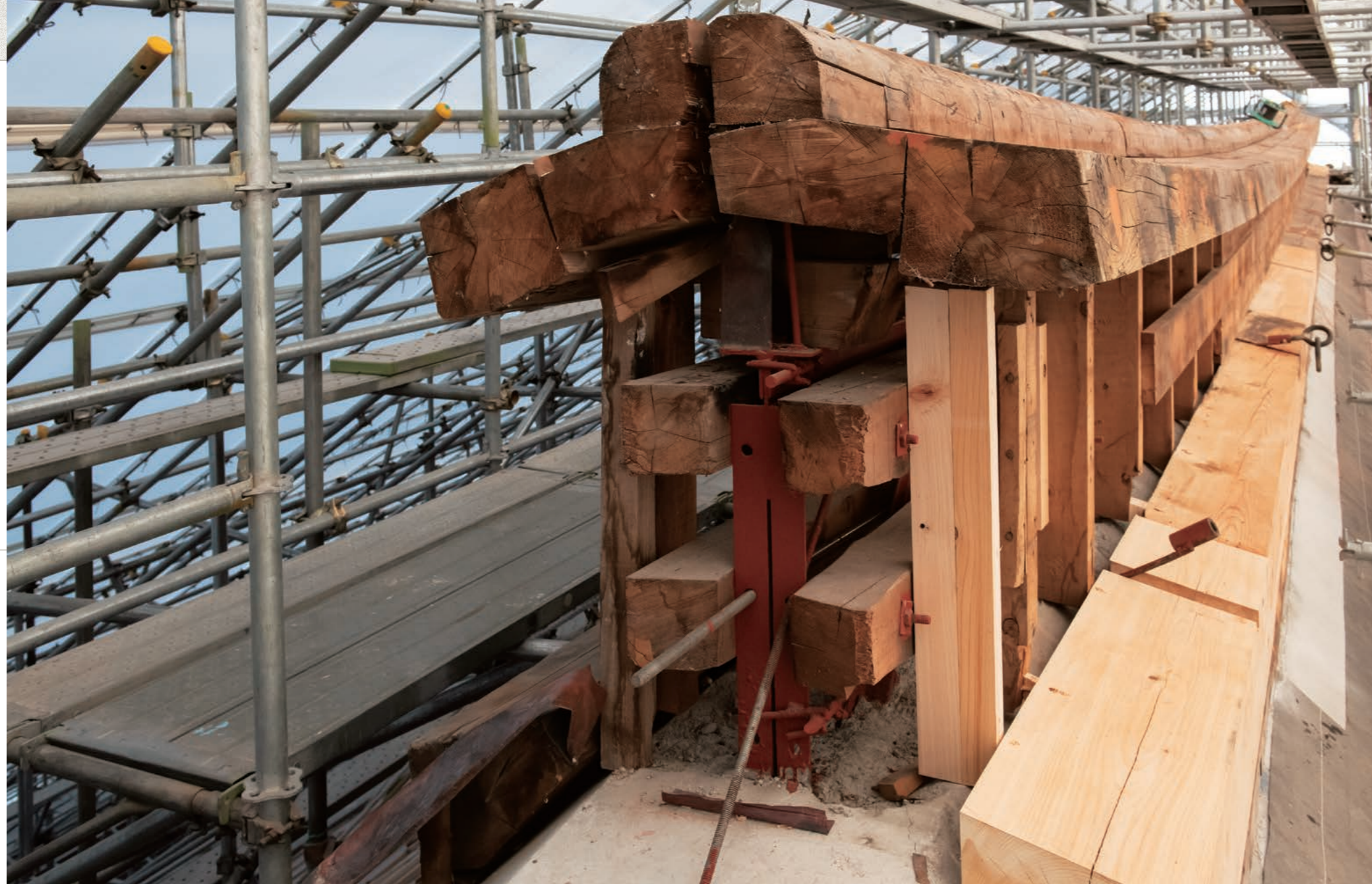
改修が進む金沢別院本堂の屋根。地上約30mの高さに位置する棟の木下地の傷んだ部分を補修しているところ。材の傷みは少なく、一部のみを新材に取り替えた。この端部に「鬼瓦」(「鬼錆(かざ)り」「大鬼」とも。p.42の写真参照)を取り付ける。本堂を覆う仮設の素屋根は特注の防災シートで製作したもの。透過性を持つため明るい環境で工事が進行している。
