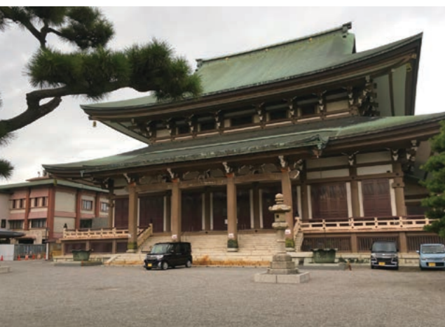
改修工以前の金沢別院本堂(2017年撮影/写真提供:松井建設(株))
