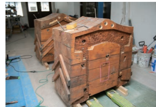
右／改修前の「鬼瓦」。上部に円筒状の「経の巻」、左右に牡丹の彫刻を打ち出した「鱒（ひれ）」が取り付けられている。中央の銚金物は宗紋の抱き牡丹。本体から経の巻の上まで高さは1.3m。（写真提供：松井建設様） 上／「鬼瓦」の木下地。銅板を被せて打ち出し、木下地とともに棟に取り付ける。既存の材はほとんど健全な状態が保たれていた。上部には「経の巻」、両側に「鱒」などを、それぞれ銅板を打ち出して取り付ける。
