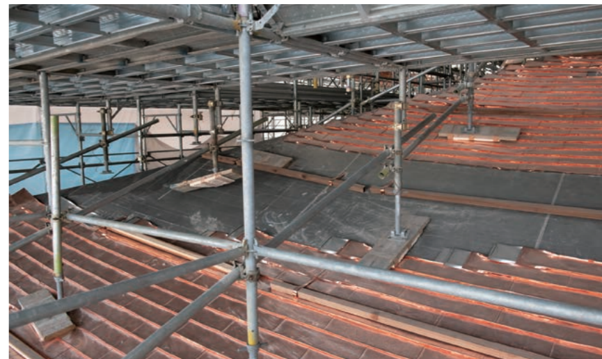
右/上層の軒からの雨落ちにより傷んでいた下層の屋根面の中ほどに、ステンレスと銅板の二重葺きが施されている。下地モルタルの上に改質アスファルトルーフィングを敷き込み、それぞれの葺板を雨落ちのラインから2m前後にわたり施工している。
