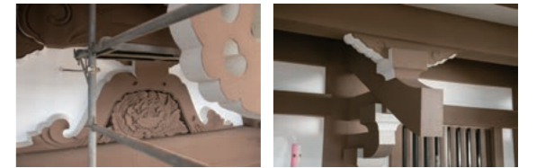
上／外壁の改修はほとんど完成している。古い塗料を剥がし、モルタル下地のひび割れを補修。打音検査で浮きが見つかった部分にエポキシ樹脂を注入して固定の上、再塗装した。組物は中空のプレキャストコンクリート製。
