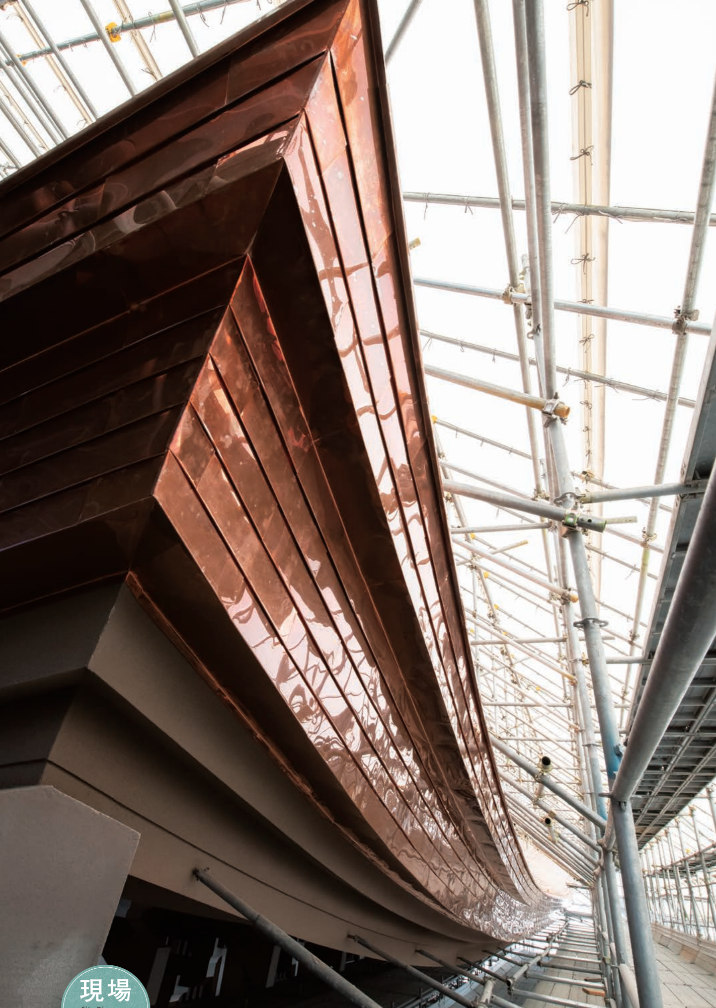
葺き上がった大屋根上層の軒。長さは約35m。改修前と同じように軒反(のきぞ)りの美しいラインが通っている。RC造の屋根本体の軒先部分は木下地で構成されており、修繕前に型板を取ることで軒先を復元している。
