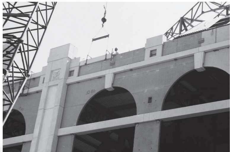
1993年、アメリカの野球場の建設現場。灰色の“Job Concrete”の上に桃色の“Architectural Concrete”を取り付けている。
