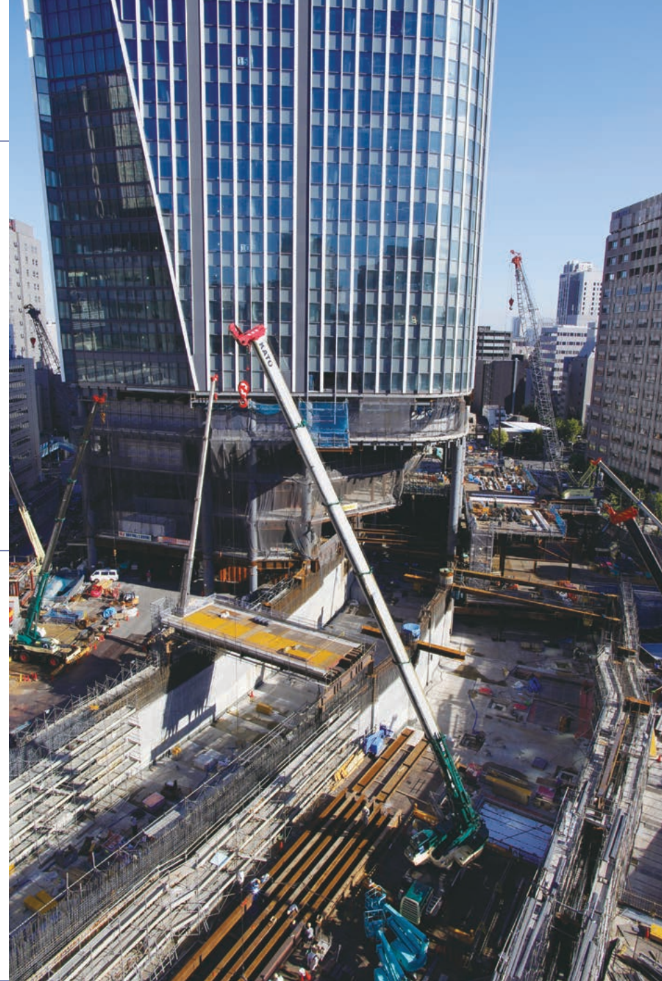
立体道路と高層部の同時施工状況
