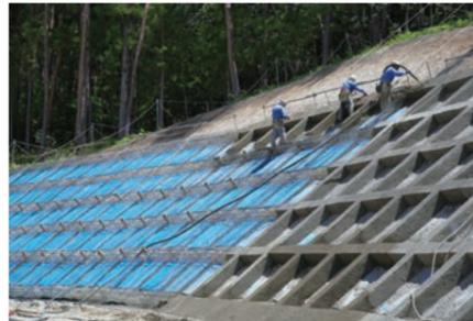
法面を補強するため法枠工が追加されたポイントも少なくない。
