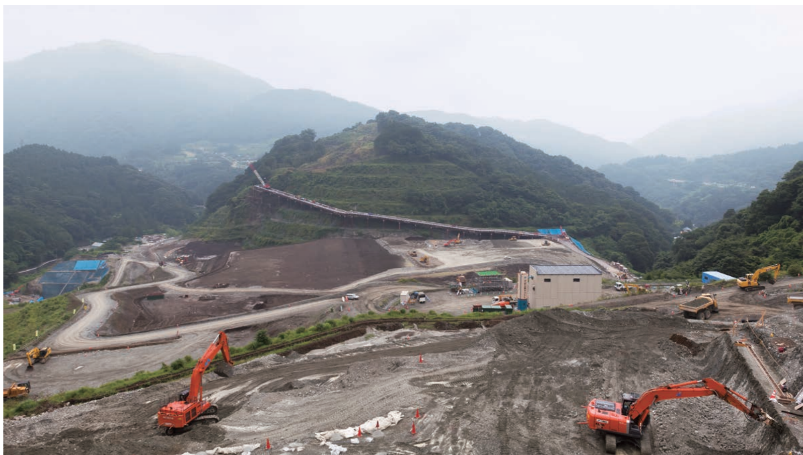
PR館からほど近い川西工事の現場。スマートインターチェンジが設置される予定の現場は、山を1つ削って整地する大規模な土工事が行われている。正面の山肌を登る仮設道路は工事用ではなく、埋蔵文化財の調査のために設けられた。ここで現場の存在感を体感し、PR館で詳細を理解することで、工事の全体像が立体的に理解できる。
