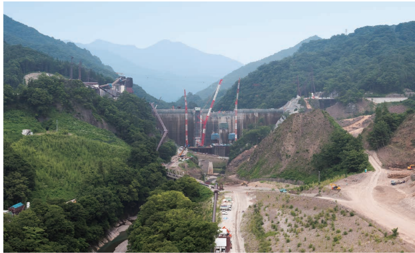
ハツ場大橋から望むハツ場ダム上流サイドの全景。竣工時にはこの一帯はダム湖の湖底に沈む。今しか見ることのできない風景だ。見学会には、ダム築造に関わる土木技術、社会基盤の重要性を広報するとともに、ハツ場の歴史や文化、建設の経緯も語り継いでいくことが期待される。
