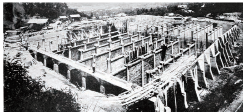
明治44年、蹴上浄水場の高区配水池（浄化し終えた水を貯める設備）の工事風景。当時の最先端技術であった鉄筋コンクリートを導入した。技術者たちは耐久性に懐疑的だったが井上の強い提案で実現。彼の先見の明がうかがわれる。[提供：京都市上下水道局]
