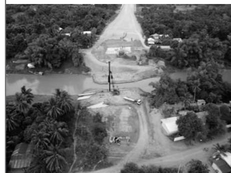
Bridge 78施工状況
