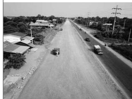
既設道路拡幅区間施工状況
