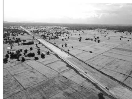
新設バイパス区間施工状況
