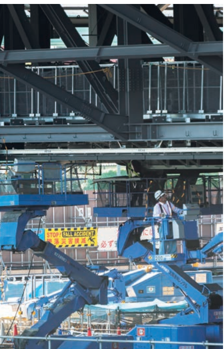
屋根の下では高所作業車や小型クレーンが密集。地上で屋根や天井の施工ができるため施工性、安全性が格段に向上した。
