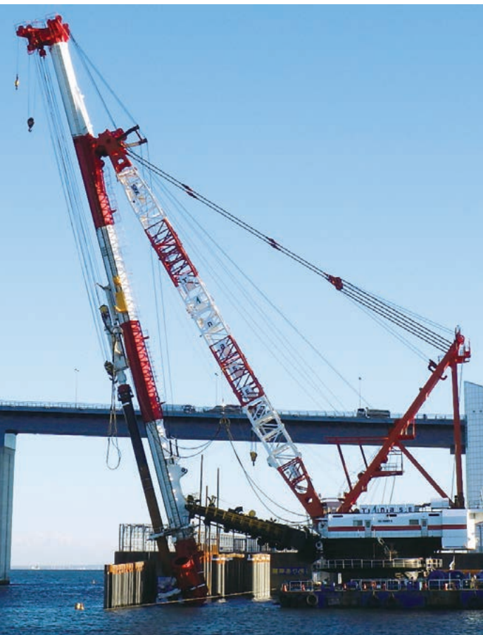
鋼管杭の打設は一昨年の暮れに始まった。ポイントによってはN値0という軟弱な海底地盤に対し慎重に打ち込んでいった。(提供：大成建設(株))
