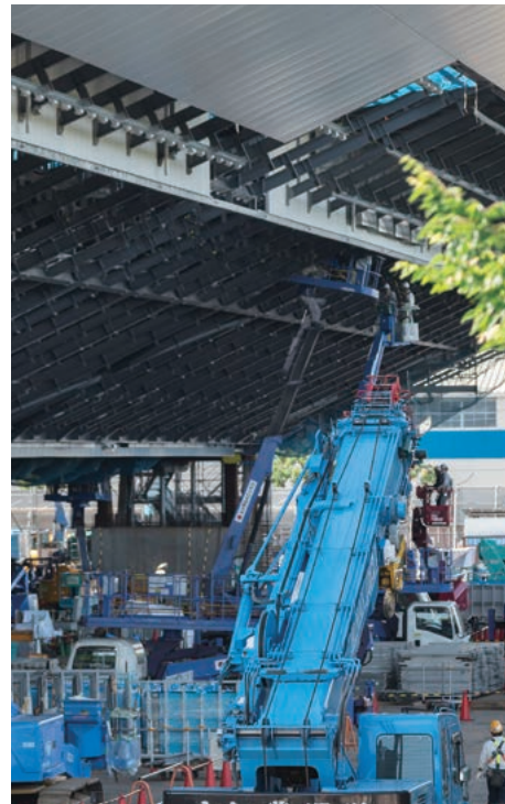
上／全景写真(2018年6月現在) (提供：東京都オリンピック・パラリンピック準備局/公式HPより) 下／外側に張り出す特徴的なひさしのパネルも地上で施工することができる。
