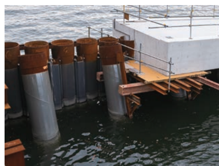
垂直方向の遮水壁の背後から斜杭を打設して支持する。二重締切堤と同等の強度を確保することができた。
