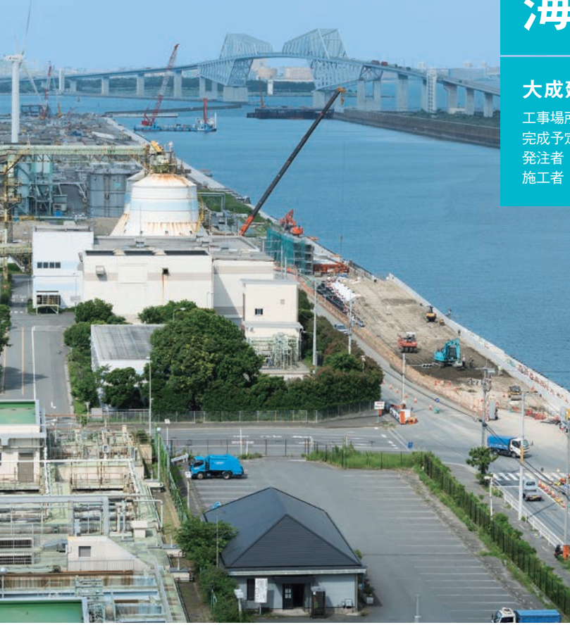
上／中央防波堤の空撮写真。写真右側が北の方位にあたる。 (提供：東京都) 左／水路幅約200mは、奇しくも競技場規格に合致していた。内側防波堤ではグランドスタンドや艇庫、並走コースの整備に着手している。奥に見える東側の締切堤は、コース内に橋を架ける作業船が出入するため、開いたままになっている。
