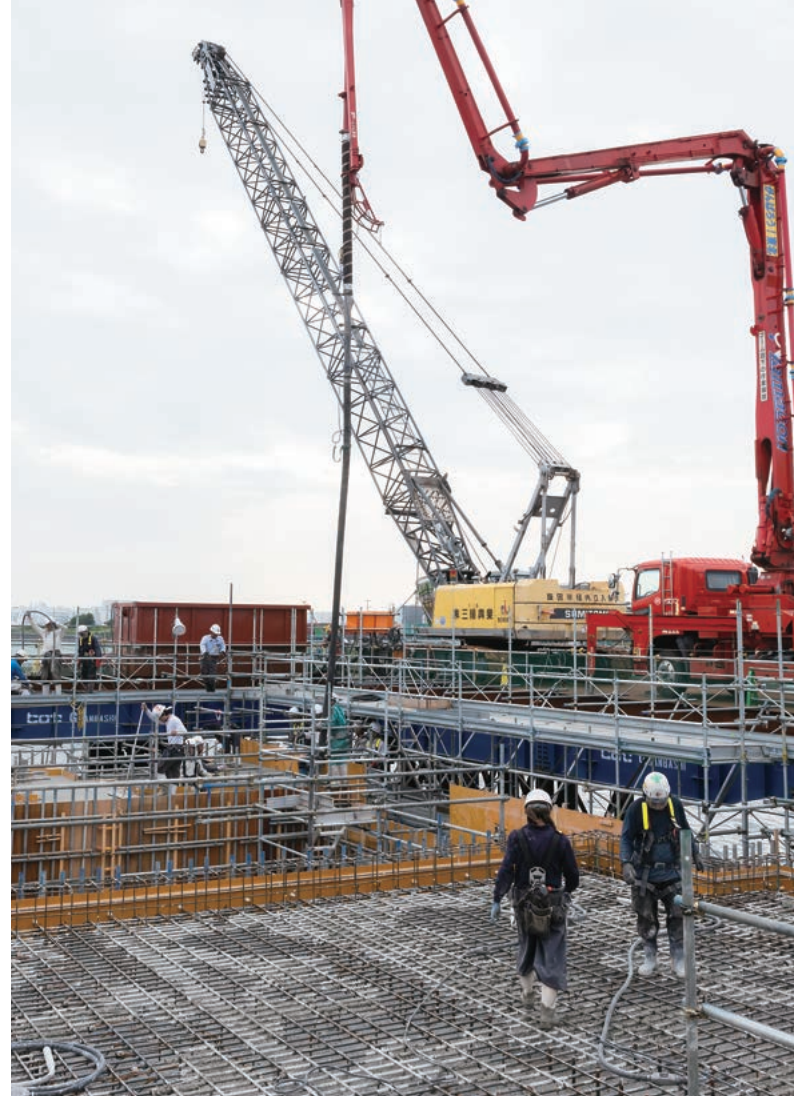
競技会場の西端にあたる締切堤では水門を設置する構造物の施工が始まっていた。
