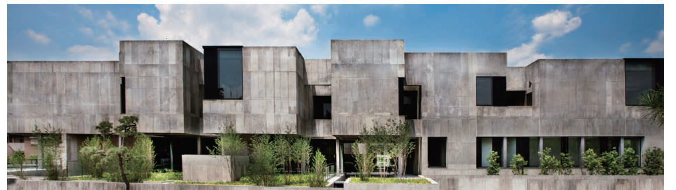
音楽室の単位が外壁を分割する。
