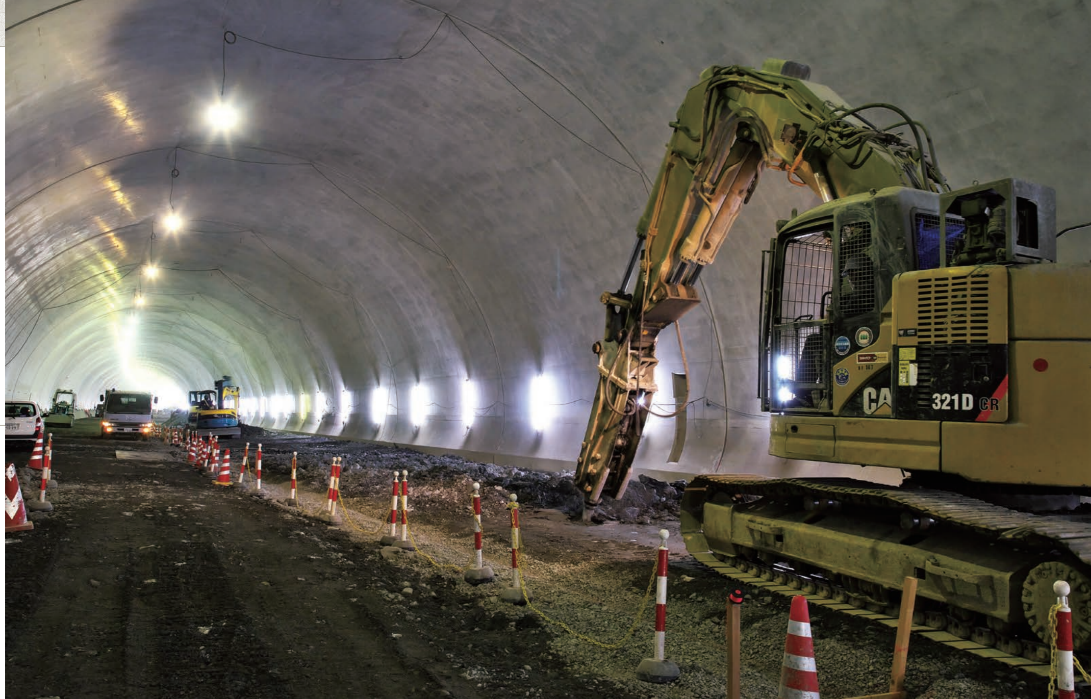
貫通した全長682mの第一トンネルではインバート工、コンクリート工が進行中だ。大きく蛇行する現道がこのトンネルによって直線ルートになる。
