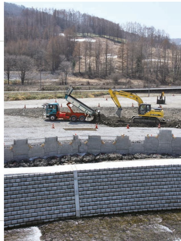
閉伊川の護岸はコンクリートを使用しないアンカー式緑化工法で行った。川の清流を保つことができる。
