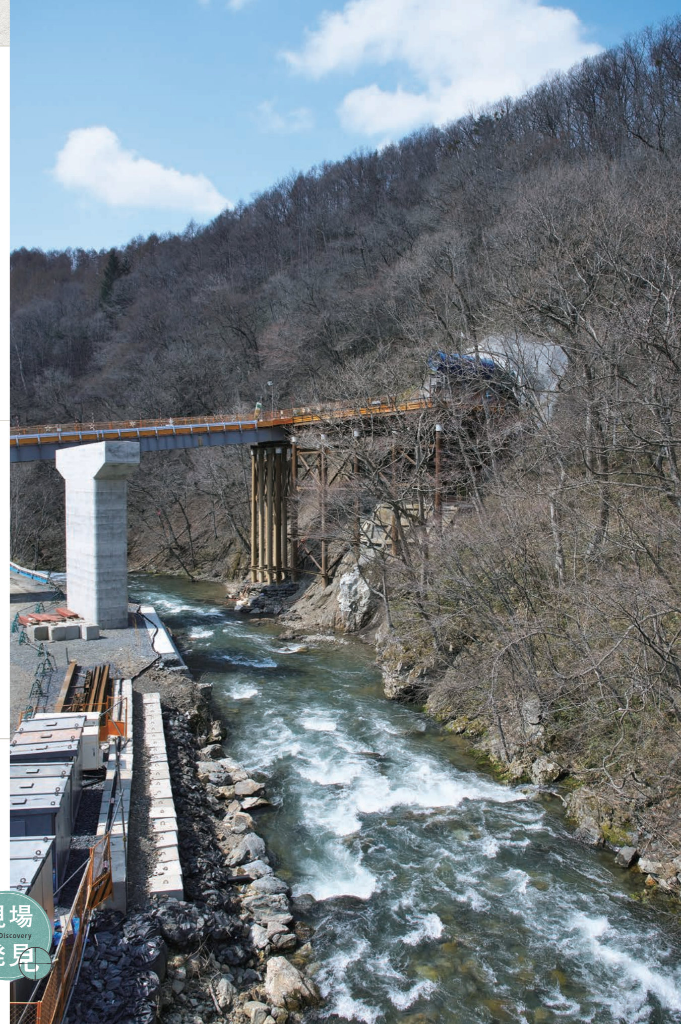
第二トンネル坑口の直下には閉伊川が流れる。この川を渡る橋梁を受ける橋脚が既に完成している。坑口寄りに橋台が構築される予定だ。
