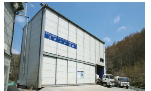
吹付コンクリートはこのスマートバッチャープラントから供給される。混合前から吹付直前まで一定温度のフレッシュコンクリートを現地で製造することができる。
