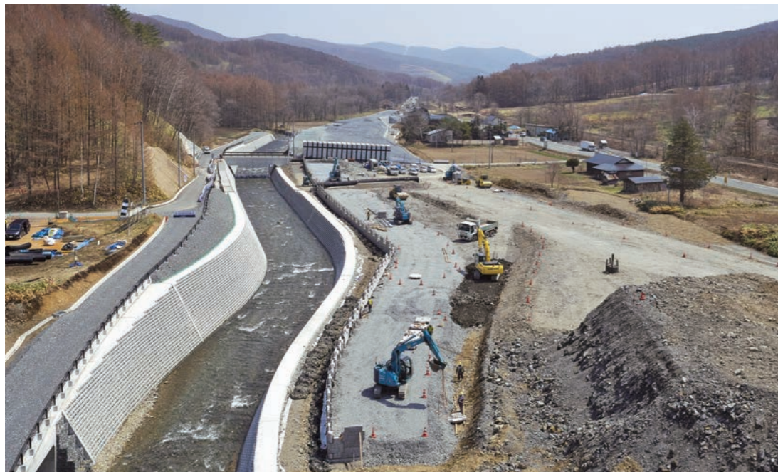
かつての閉伊川は写真 右手に大きく蛇行して いた。現在、その位置 に新しい本線を通す ため盛土工事が進行 中。盛土の高さは最大 20mに及ぶ。
