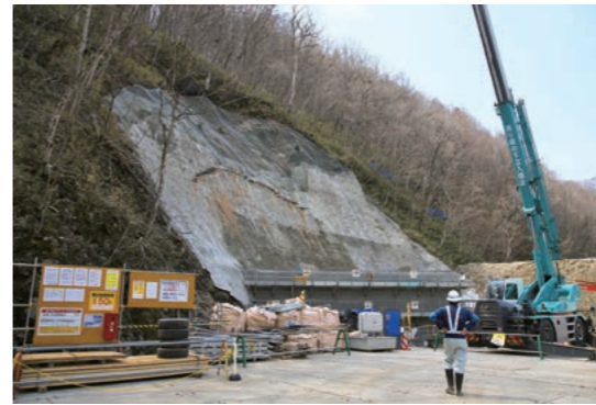
第二トンネルの起点側では貫通の準備が進む。 このすぐ裏側にJRの線路が走っている。
