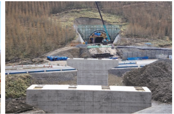
第二トンネルを背に第一トンネルの坑口を望む。 その下を現道と閉伊川が走る。
