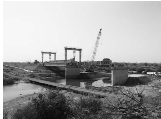
主桁架設状況 (カラ橋)
