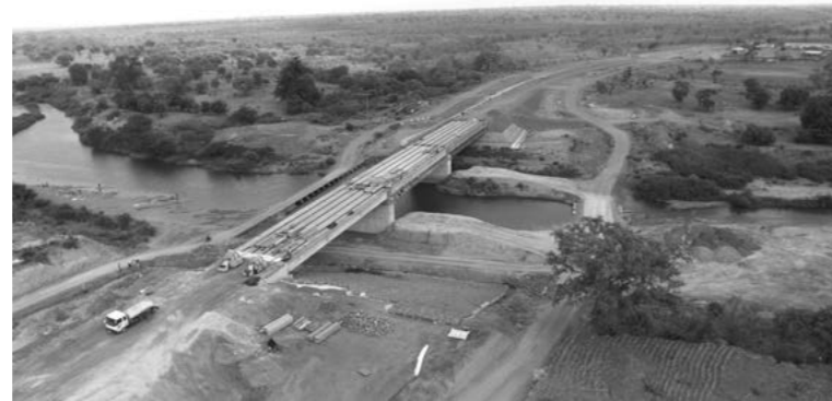
現場状況 (カラ橋)
