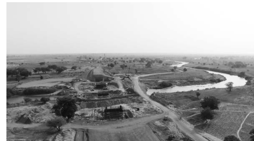
現場状況 (クモング橋)
