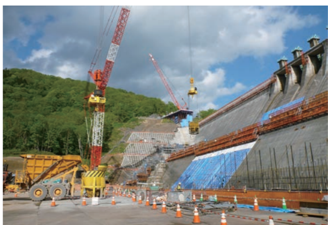
上/ドローンで下流側上空から撮影された新桂沢ダム工事の様子。 右下/ダム堤体に設置された自動スライド型枠。大幅な省力化と時間短縮を達成した。 左下/工事中の新桂沢ダム堤体を見上げると、その威容に圧倒される。 (3点とも提供：鹿島建設株)
