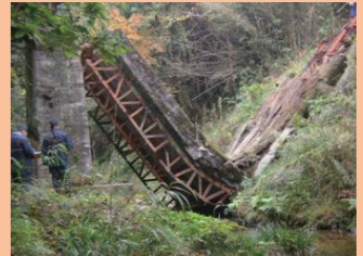
【道路橋の落橋事故(2007年)】
