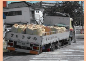
【下水道管きょに起因した道路の陥没事故(2009年)】
