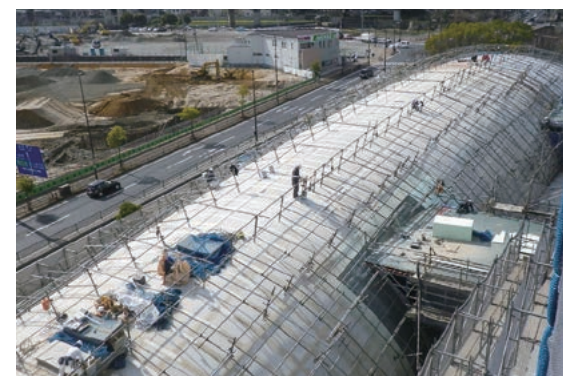
上/リングアーチ構造の外観 下/低層棟の施工風景
