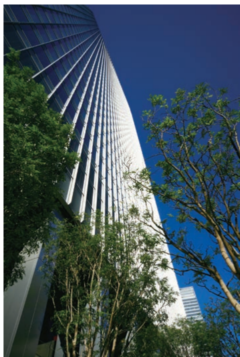
サウスタワー。アルミフィン反射により様々な表情がある外観
