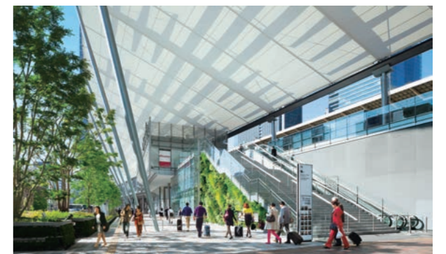
東京駅八重洲中央口を膜構造の大屋根が覆う。
