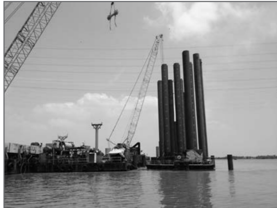
鋼管矢板基礎工事
