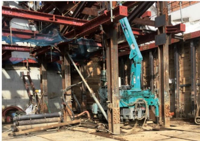
杭工事の様子。仮設フレームが設置されている状態で25本の場所打ち杭工事を行うため、狭い敷地などでの施工に適したBH工法が採用された。この工法の特徴の一つは作業高さが低く、搬出入がしやすいコンパクトな重機を使えることだ。
