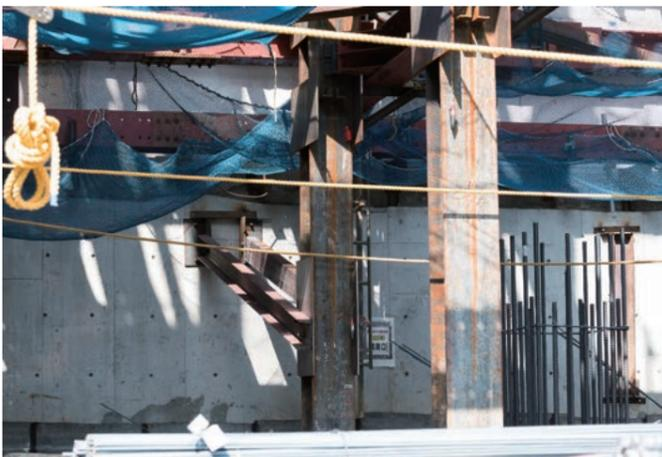
右/背後の山留の状況。支柱に斜梁を取り付け、土圧を支えている。
