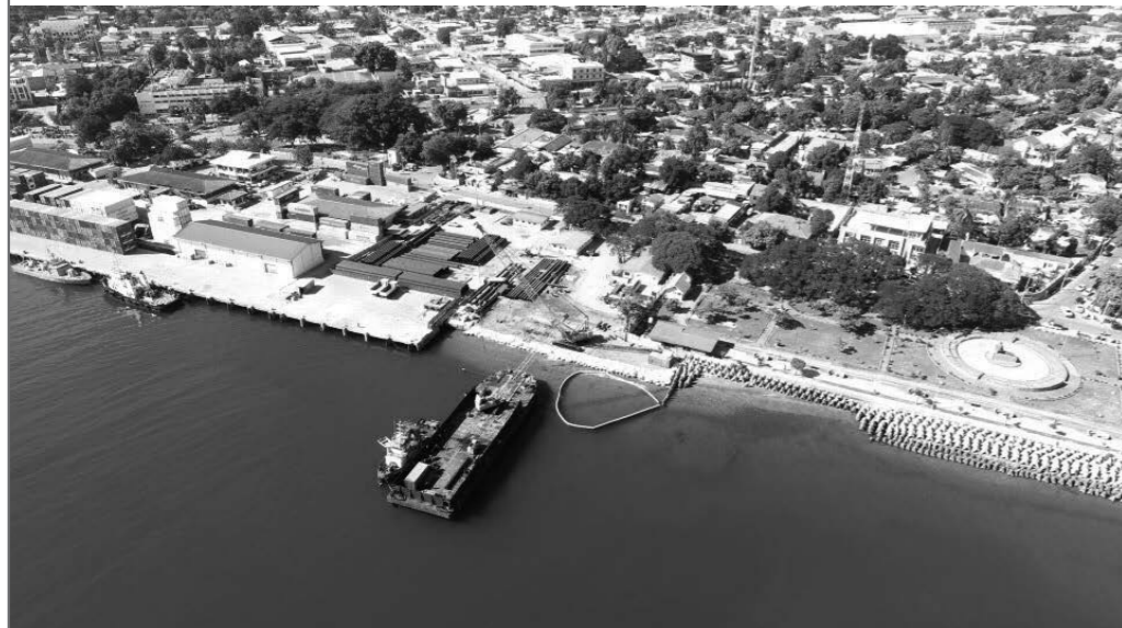
工事現場全景
