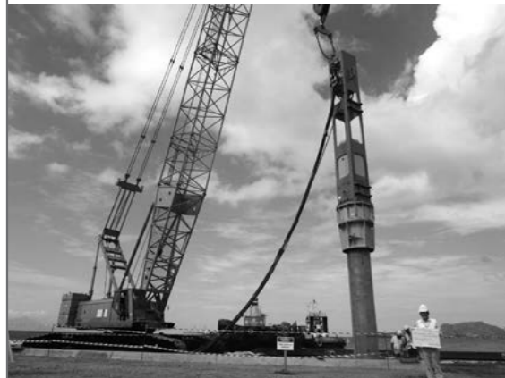
鋼管杭打設工事
