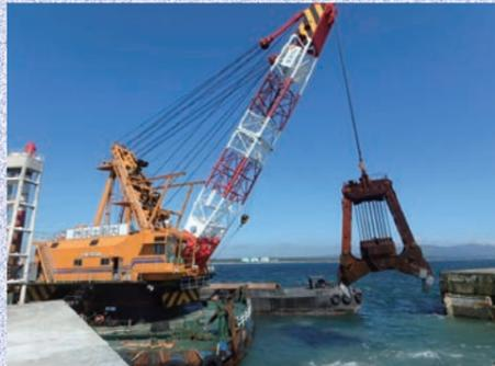
グラブ浚渫船、重量バケットによるケーソンの取り壊しと撤去作業。海底の状態をソナーのデータで把握しながらスムーズに施工。(提供: 五洋建設株)
