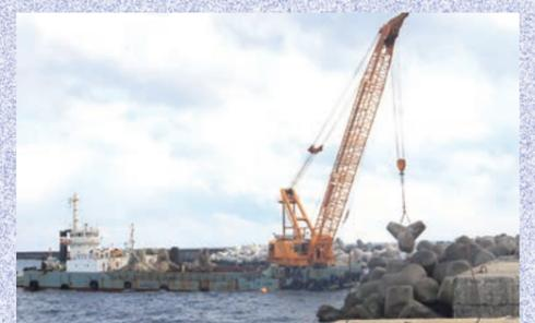
上/クレーンオペ室での誘導モニター確認 下/モニターで状況を確認しながら波消ブロックを置き換えていく。(提供:五洋建設株)
