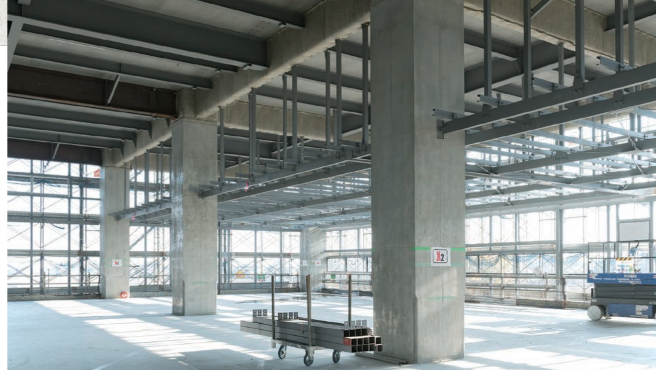
3階建ての1フロア当たりの面積は約7,600㎡。梁下に天井下地が組まれた箇所には、事務所スペース(200㎡)とトイレなどのユーティリティスペース(100㎡)が各階に設けられる。
