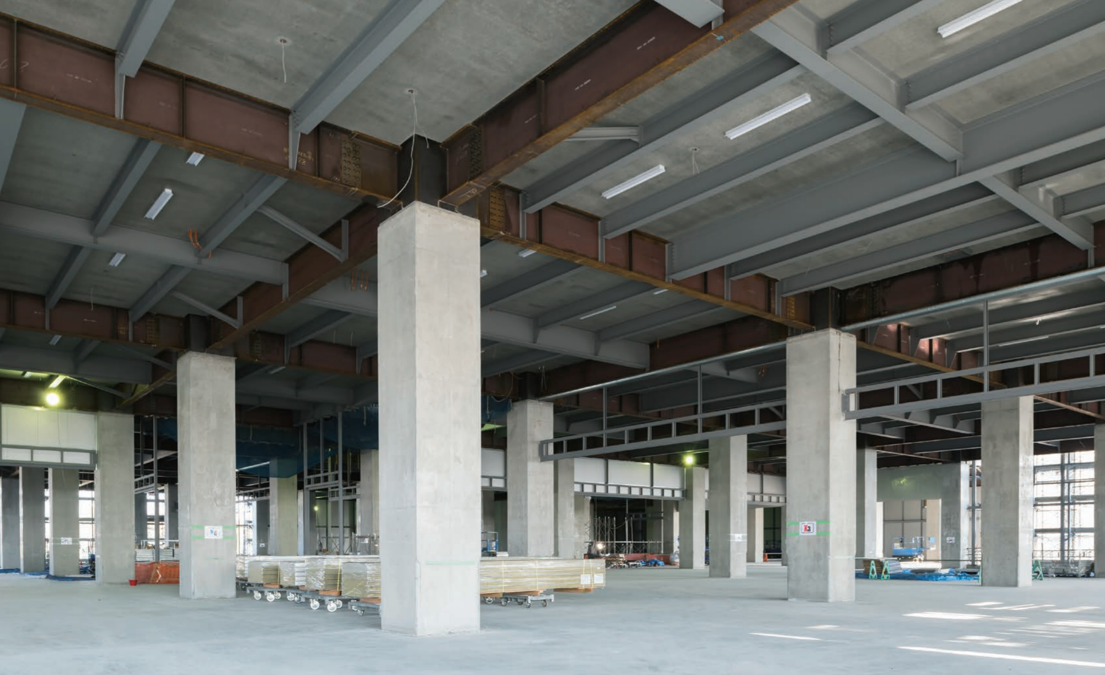
内部の仕上げ工事が進む2階フロア。躯体は鉄筋コンクリート造の柱と、鉄骨造の梁を組み合わせたRCS造を採用。鉄骨造の物流施設の倉庫よりも柱の剛性が高く、鉛直ブレースを設置していないため、大スパンで機能的な空間となっている。
