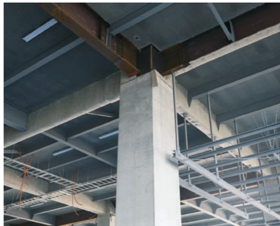
昨年10月から行われたRC造の柱の施工状況。鉄筋を現場で先組みし、クレーンで揚重、設置。開発したL形のシステム型枠を2本合わせてコンクリートを打設し、各階79本を施工した。写真の左奥は先組鉄筋。その右隣は型枠が組まれた状態。右手前2本は脱型後。(提供：東洋建設(株))
