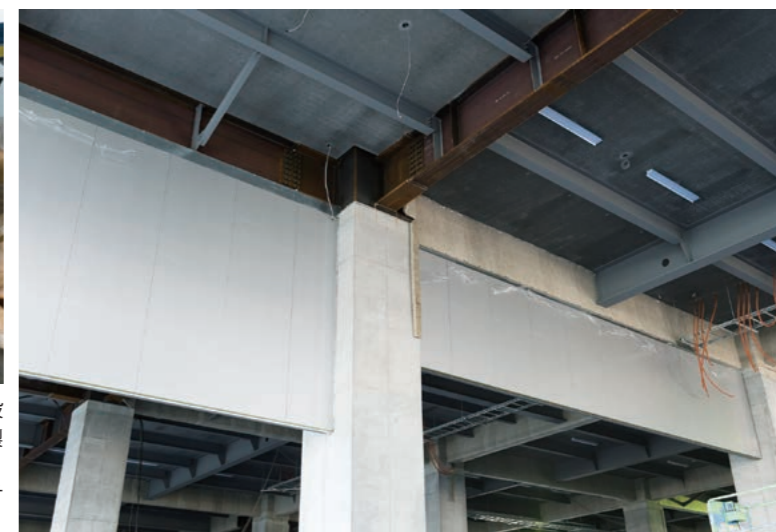
右/フロアは防火区画により5分割され、シャッターが設けられる。シャッター上部の区画壁は厚さ100mmの金属製の耐火断熱パネル。 左/ロックウールの耐火被覆材。鉄骨の大梁などに巻き付ける。
