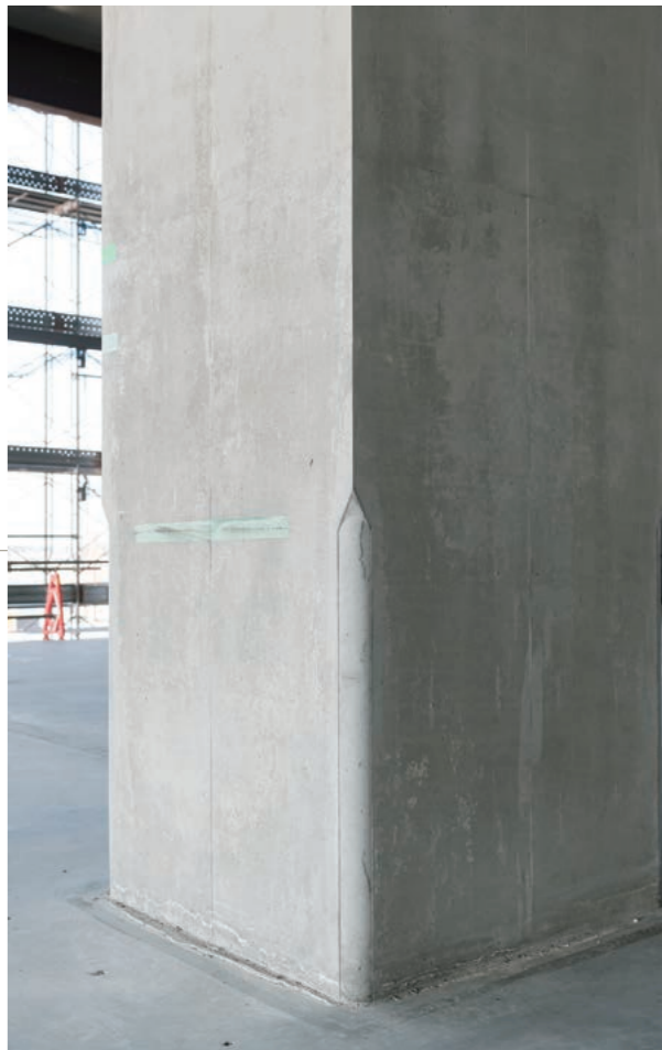
倉庫内作業でフォークリフトや台車などが柱に当たり、コンクリートのコーナー部が欠けるのを防ぐために丸味をつけている。コーナー部材を型枠にセットしコンクリートを打設したもので、仕上がりも美しい。発注者に提案した手法の一つ。
