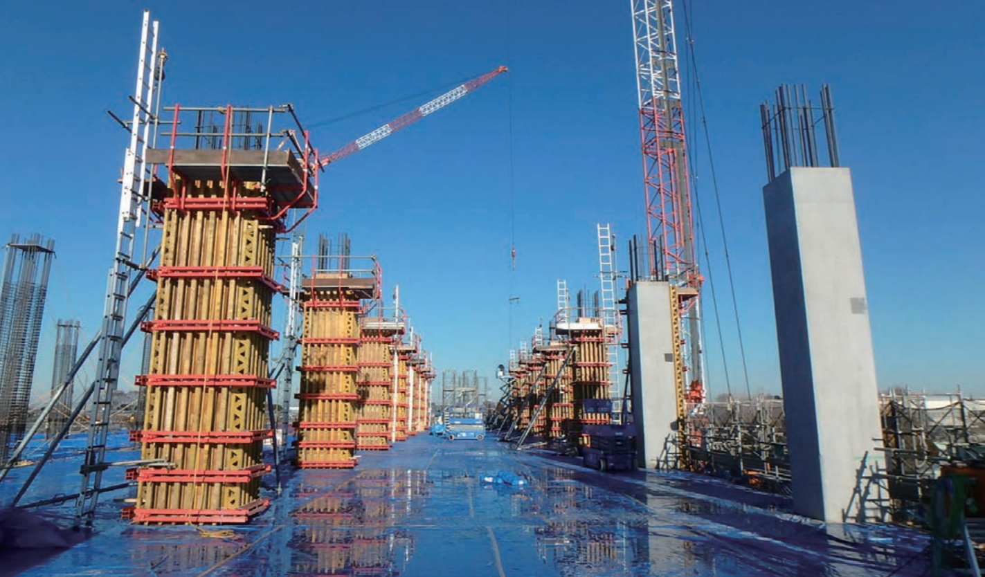
昨年10月から行われたRC造の柱の施工状況。鉄筋を現場で先組みし、クレーンで揚重、設置。開発したL形のシステム型枠を2本合わせてコンクリートを打設し、各階79本を施工した。写真の左奥は先組鉄筋。その右隣は型枠が組まれた状態。右手前2本は脱型後。(提供：東洋建設(株))
