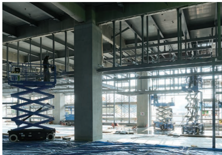
右/高所作業車で天井の塗装作業を行っている様子。1階フロアの階高は約7m。事務所スペースの天井下地が組まれた間を移動しながらの作業。
