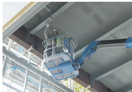
右/高所作業車で天井の塗装作業を行っている様子。1階フロアの階高は約7m。事務所スペースの天井下地が組まれた間を移動しながらの作業。
