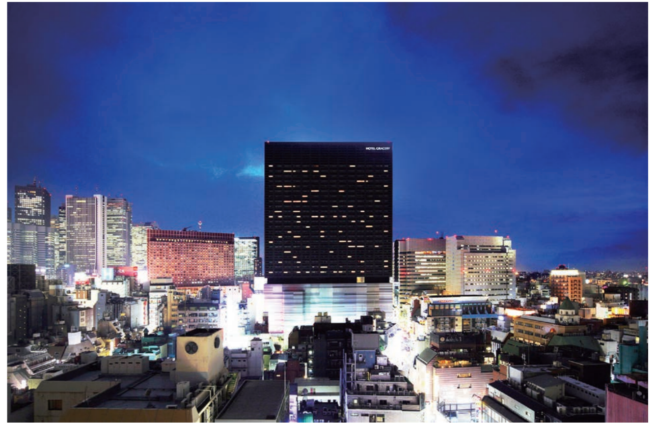
高層棟長手面の横長客室窓
