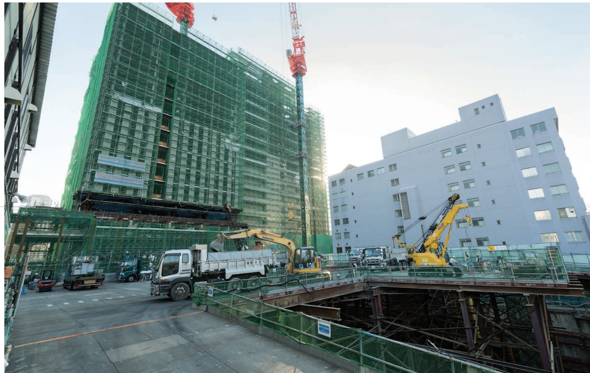
15階建ての新庁舎の北面。躯体工事が終了し、内外装に着手。中間階免震を採用し、2階と3階の間に免震層を設けている。手前に構築されている構台は3棟で共有。構台の地下では分譲マンション(住宅棟)の掘削が終了。
