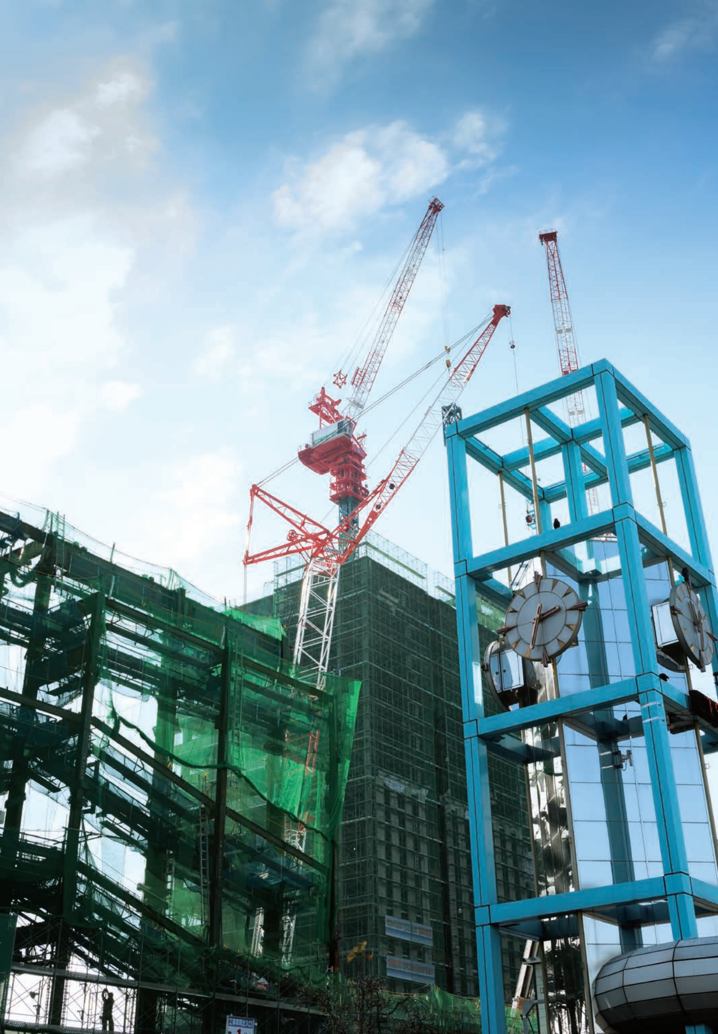
公園通りから工事中的新庁舎(中央)と新公会堂(左)を見る。
