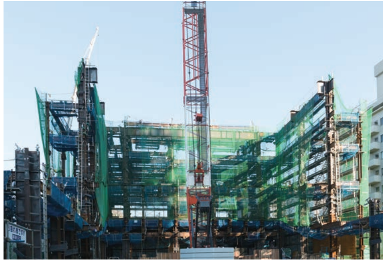
鉄骨の建方が進む新公会堂。写真手前がステージ側、奥が客席側。鉄骨が斜めに掛けられている箇所は2階席、3階席の両側。
