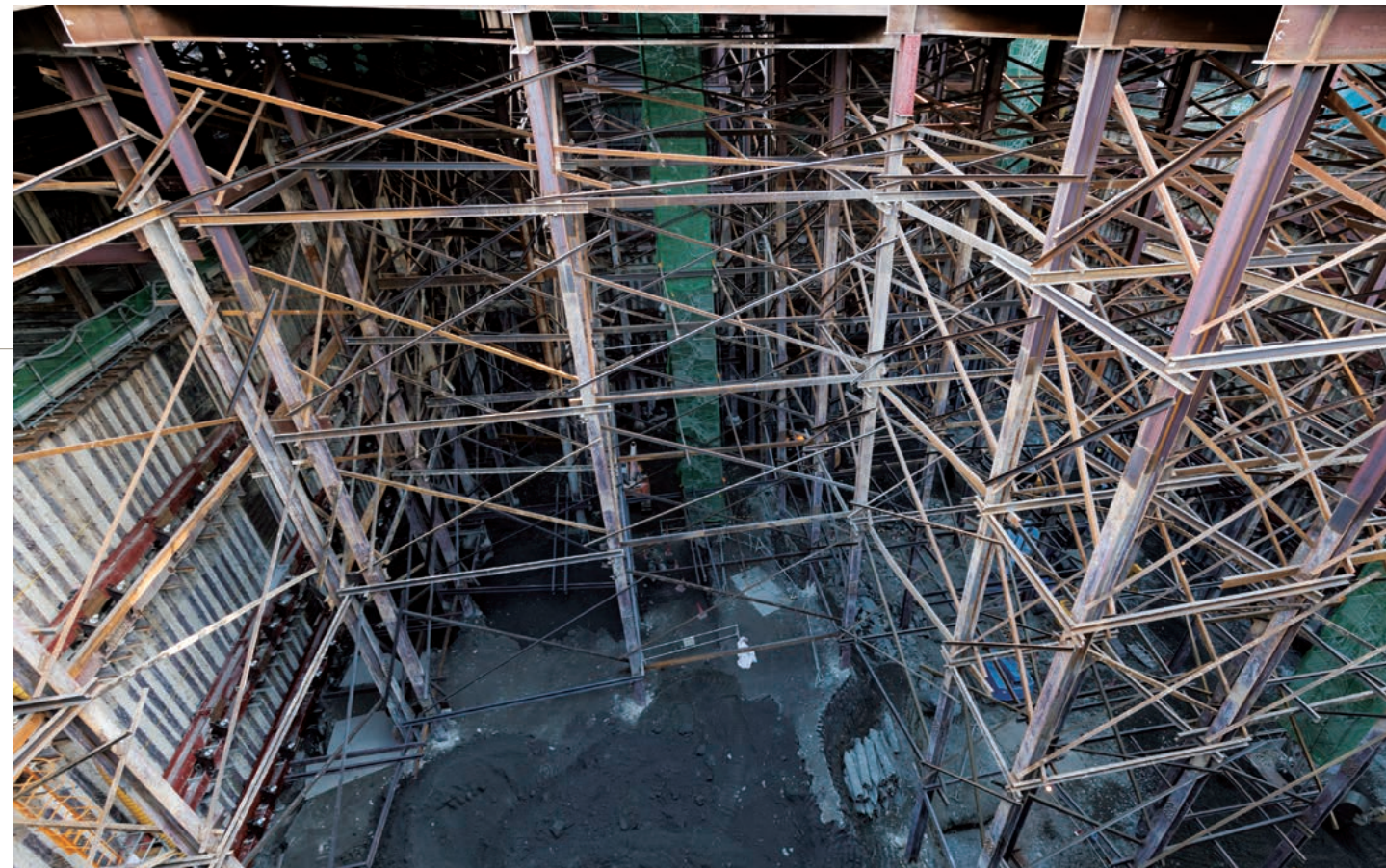
分譲マンション(住宅棟)の地下掘削。四方の山留にアースアンカー工法を採用。隣地建物の地下杭に干渉しないよう、位置などが計算されている。掘削は最終段階。年初から直接基礎を設け、地下躯体に着手する。
