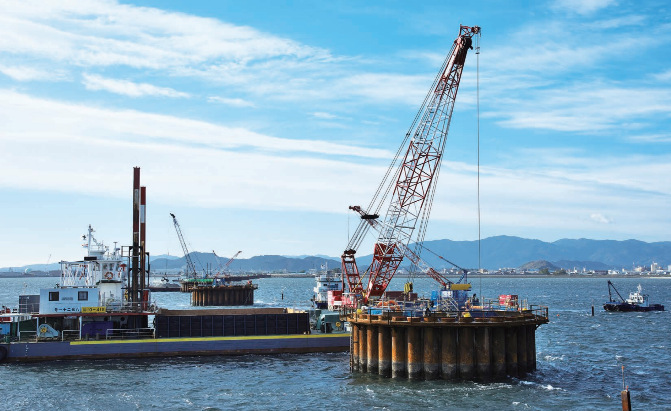
吉野川大橋の橋脚工事現場。躯体構築が進むP1橋脚。その奥に見えるのがP2、さらに約1km離れた対岸にP11橋脚がある。3基の現場が同時に動いている状況だが、それぞれに2名の担当職員を配置し、確かなチームワークのもと施工を進めている。
