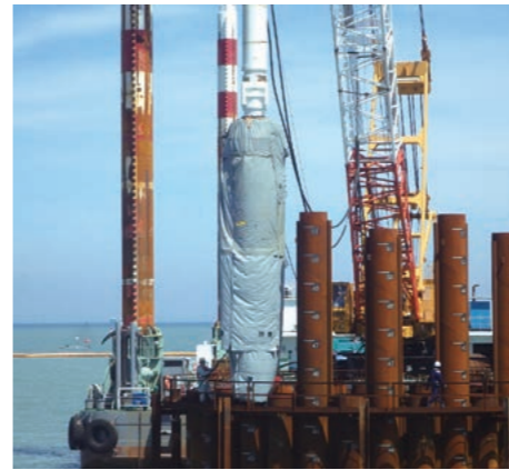
鋼管矢板の打設にあたってハンマー部に消音装置を取り付け、さらに全体を防音シートで覆い、打音と振動を最小限に止めた。現場周辺にも汚濁防止膜を張り巡らせ、濁水の流出を抑制した。（提供：東亜建設工業（株））
