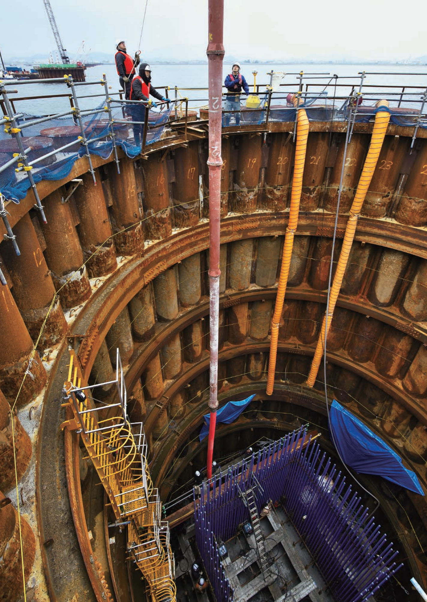
鋼管矢板の上に回廊のように設けられた足場の上で玉掛け担当者がトレミー管の挙動に目を光らせる。コンクリートを送り込む作業船のオペレーターと、井筒の底部でコンクリートを打設する作業員の呼吸を合わせる事が最大のミッションだ。
