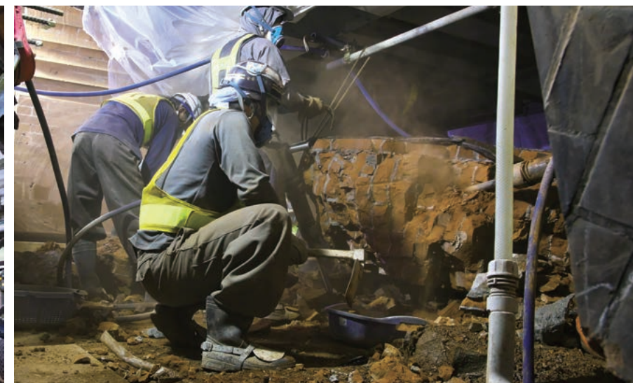
100年前に施工されたレンガをはつついていく。重機を入れる余裕がないため作業はおのずと手作業になるが、これがとてつもなく硬い(右)。階段とエスカレーターを支える铸铁製の支柱には社名と日付が刻印されていた。明治の技術者たちの技と矜持がいたるところに隠れている(左)。
