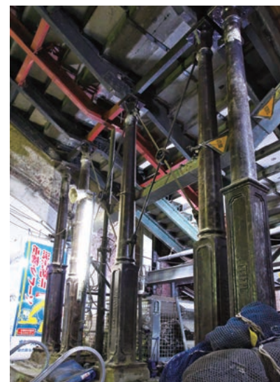
100年前に施工されたレンガをはつついていく。重機を入れる余裕がないため作業はおのずと手作業になるが、これがとてつもなく硬い(右)。階段とエスカレーターを支える铸铁製の支柱には社名と日付が刻印されていた。明治の技術者たちの技と矜持がいたるところに隠れている(左)。
