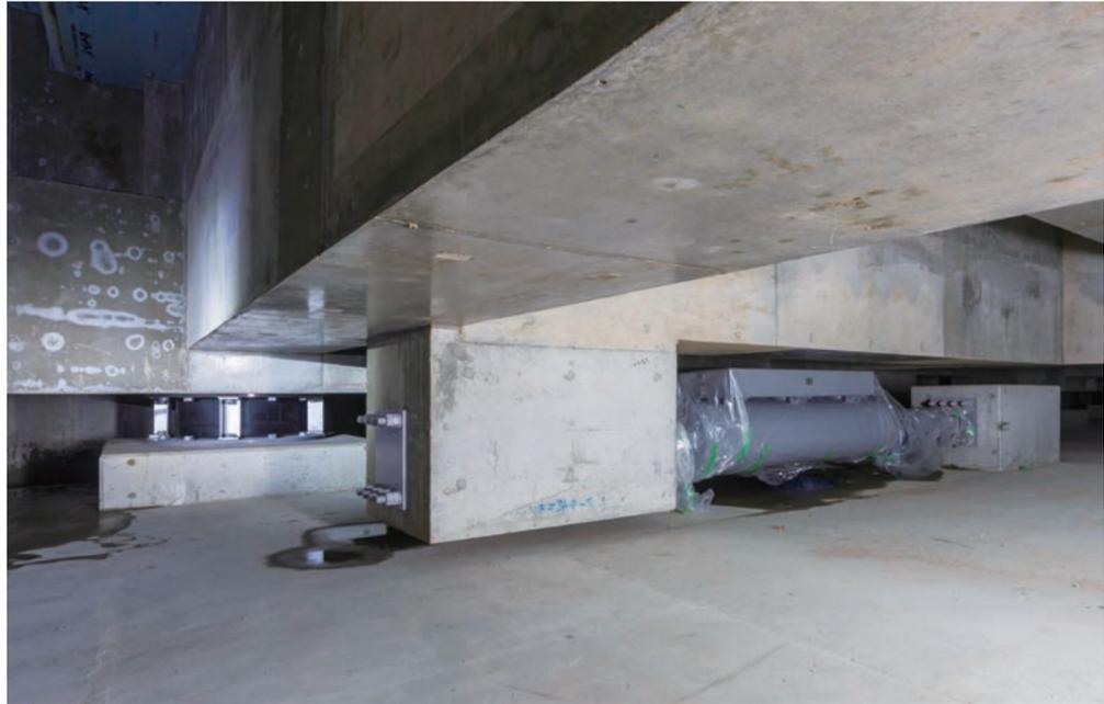
基礎に設置された免震装置。左は高減衰積層ゴム、右がオイルダンパー。積層ゴムで建物を支え、地震エネルギーを吸収しつつ水平移動に変換し、オイルダンパーで揺れを吸収する。
