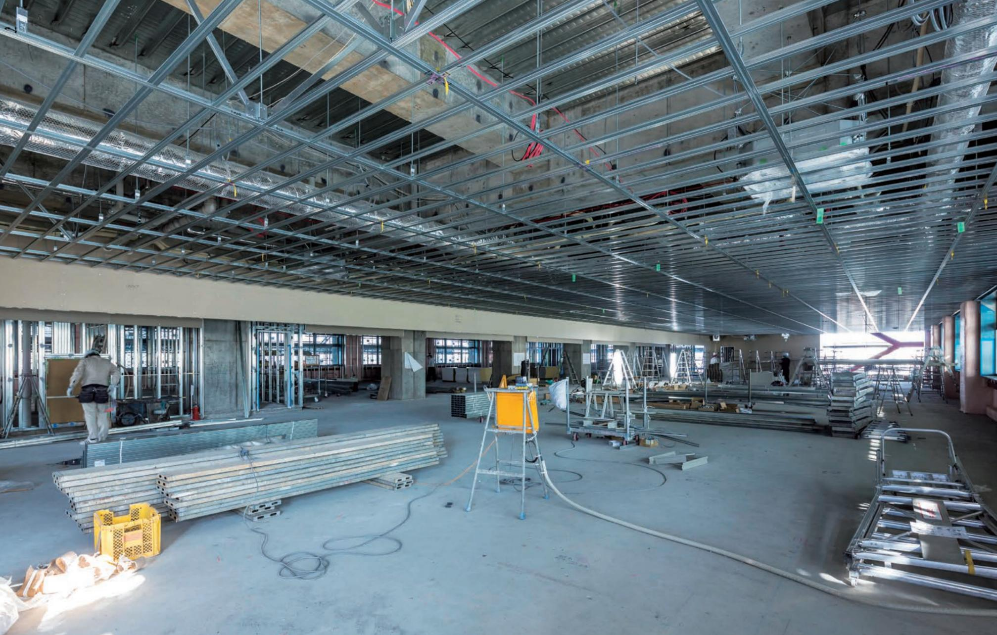
高萩市本庁舎2階フロアの南側にある執務空間。短辺方向にプレストレスト・コンクリートの梁を施工することで大スパンの空間をつくりだしている。様々なセクションのレイアウト変更に柔軟に対応できる。
