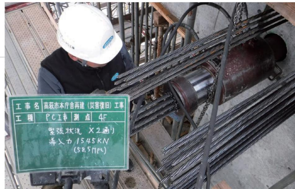
右上／プレストレスト・コンクリートに通すPC鋼材。1本のワイヤー径は12.7mm。スチールの燃り線を12本燃り合わせたものを用いている。写真は端部の定着具。（提供：株木・日興JV）
