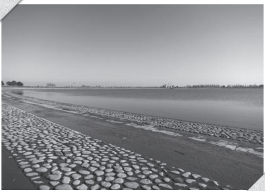
渡良瀬貯水池
