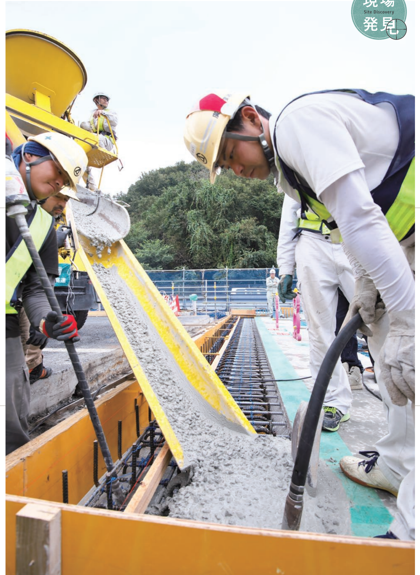
架設したプレキャストPC床版の端部にコンクリートを打設。現場にコンクリートが供給されるたびにその性状を精緻に確認したのち慎重に充填していく。
