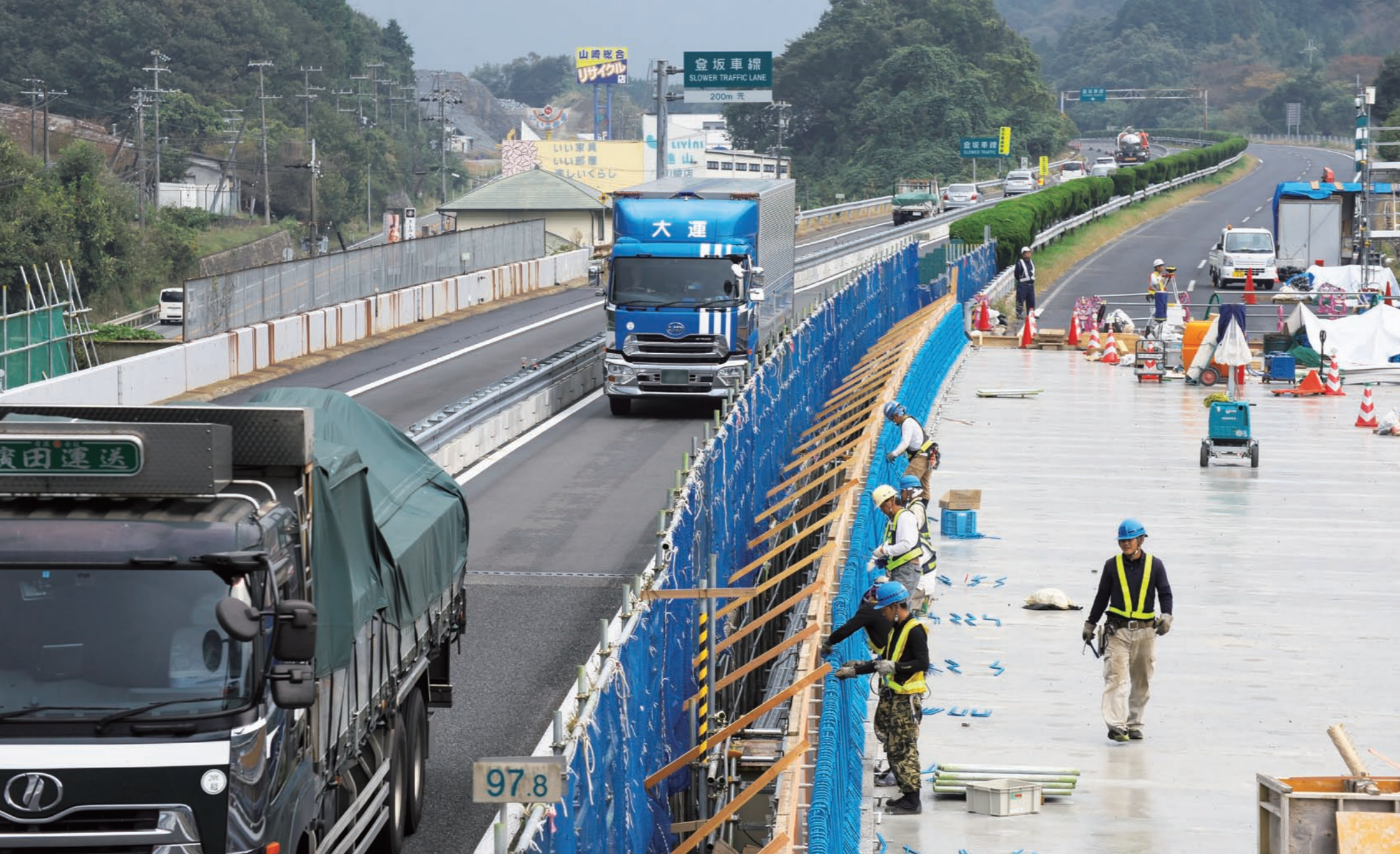
コンクリート床版の取り替え工事が進む安志橋の現場。片側二車線のところを昼夜連続対面通行とし、全面通行止めをすることなく高速道路を供用したまま施工する。安全対策には万全を期している。
