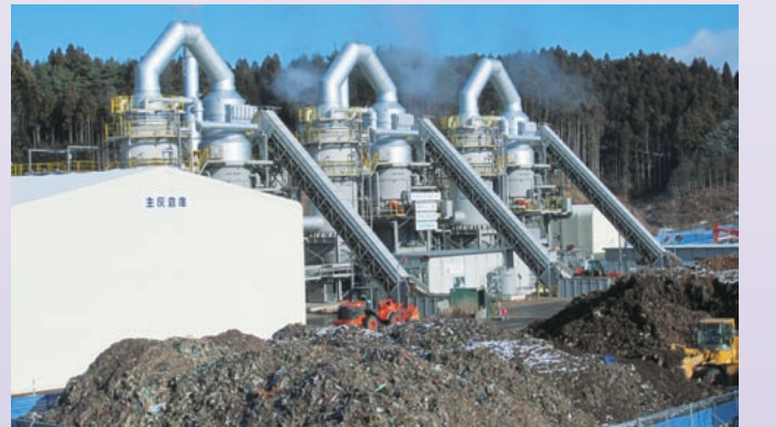
災害廃棄物処理 災害で発生した廃棄物は選別され、多くが建設資材にリサイクルされる。
