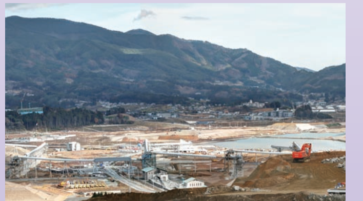
陸前高田震災復興事業 山から切り出した土砂をベルトコンベアで運び、大規模な造成工事の工期短縮を図った。
