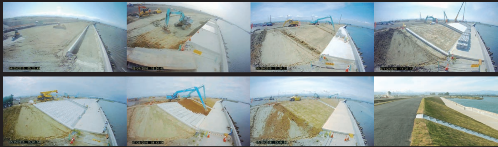
タイムラプスで記録された現場の映像。30秒間隔で高精細な静止画を記録する。動画より解像度が高く、工事資料、教育素材としても容易に編集できる。(提供：(株)橋本店)
