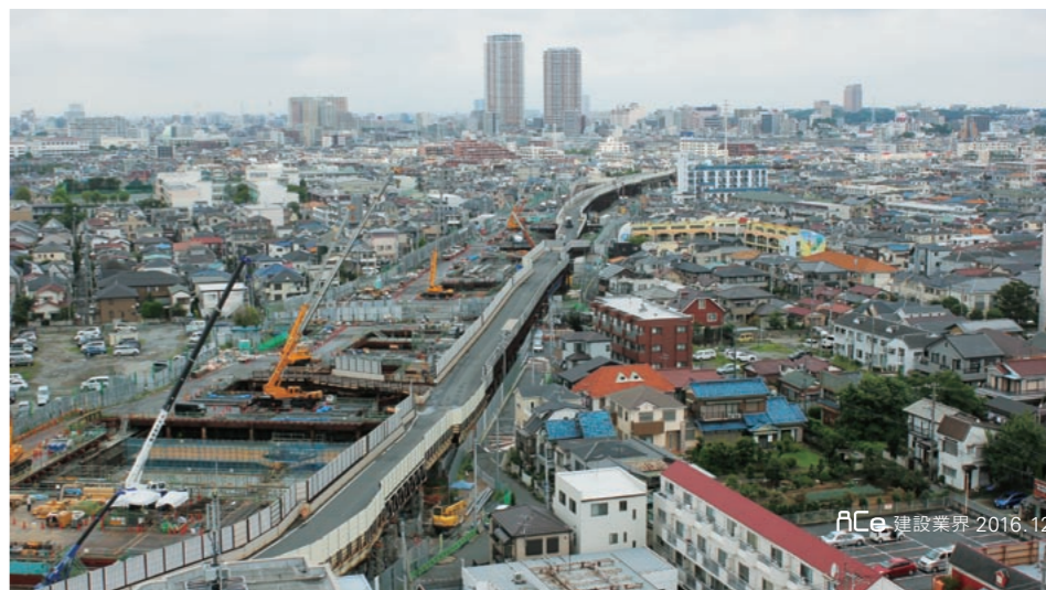
来年度の開通を目指す東京外環自動車道。一帯は住宅街、一日も早い完工が期待される。(提供：清水建設株)
