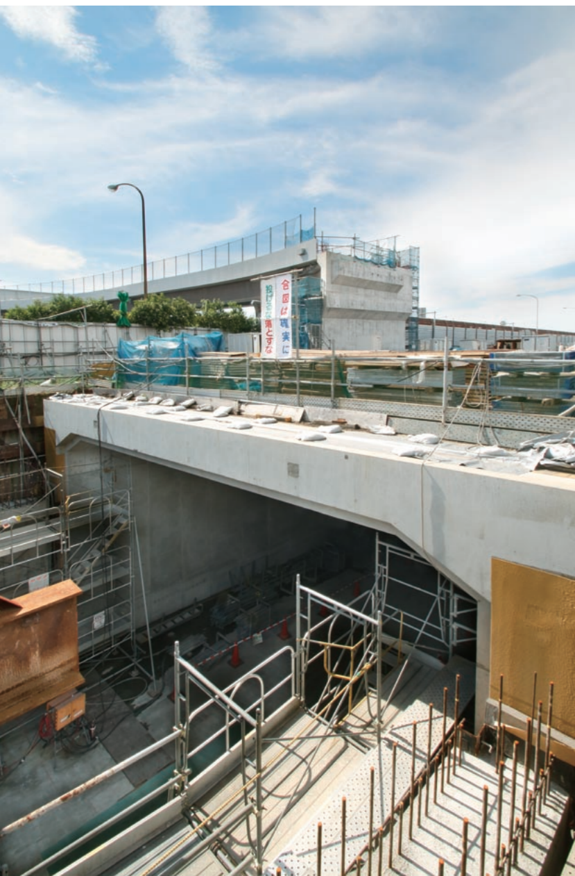
プレキャスト工法によって構築された京葉道路に接続するHランプのボックスカルバート。この上部に京葉道路をオーバーブリッジする跨道橋の橋台が築造される。
