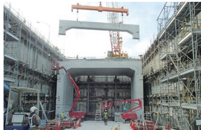
工場から陸送された函体を200t吊のクローラー・クレーンで据え付ける。函体全体の完成度を確実にするため、各ブロック据え付け時の精度管理は精緻を極めた。(提供：清水建設株)
