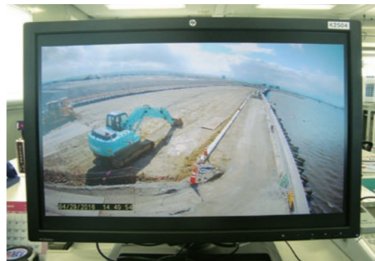
記録された映像はデータベースに取り込まれ、事務所のPC、現場のタブレットで即座に共有される。視覚的に不安全行動、品質確認を確認するツールとしても活用された。(提供：(株)橋本店)
