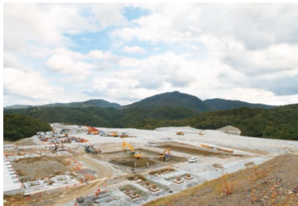
新名神高速道路切畑トンネル工事の現場は全長4.4kmにおよぶ。サービスエリアの切盛土工事、橋梁下部工事も抱える広大な現場だ。
