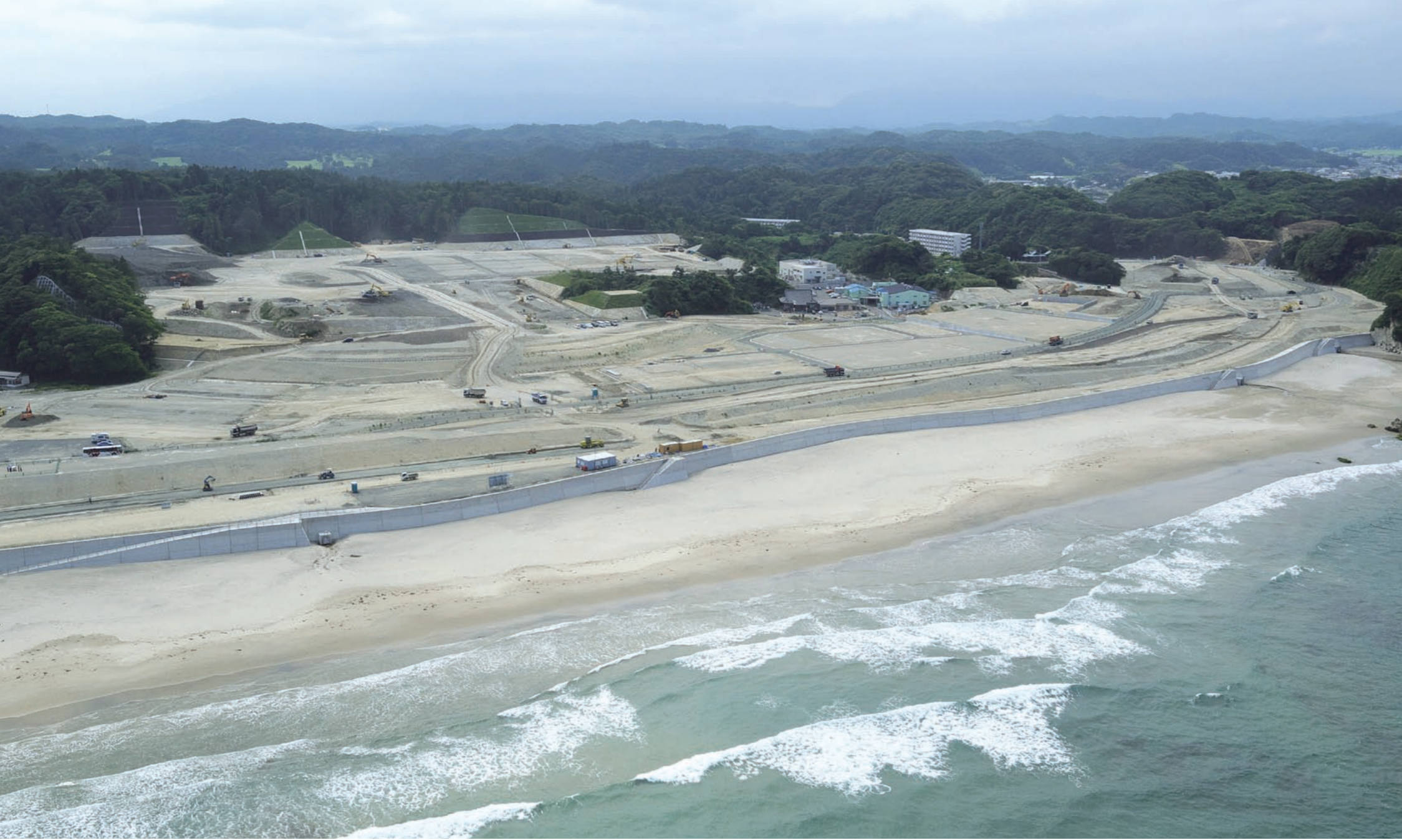
工事が進む薄磯地区。陸側の山を切り崩し、その土砂で緑地などの公共用地や住宅地を造成する。整備された区画から順次引き渡しが始まっている。美しい海辺のまちの姿が見えてきた。
