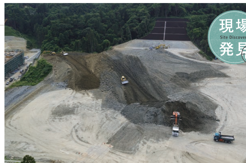
上/現場内には生活道路が縦貫し、一般車両とダンプが輻輳、児童たちがバス通学する小学校も立地する。市民の日常生活を支える既存のインフラを維持するため、安全には細心の注意を払っている。 下/取り扱う土量は膨大だ。どれだけ土を動かしたか、土砂の排出量、搬入量の計測には3Dスキャナカメラを導入した。人力での測量を大幅に減らすことでスピードアップを図った。
