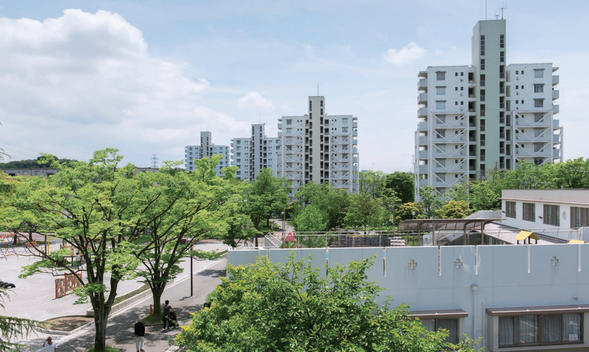
多摩ニュータウンの広さは約2,884ha、東西約15km、南北約5kmにおよぶ。いまでは約20万人が暮らす都市が形成された。手前の2棟は耐震改修工事が済み、外壁に銅製フレームと制震ブレースが設置されている。
